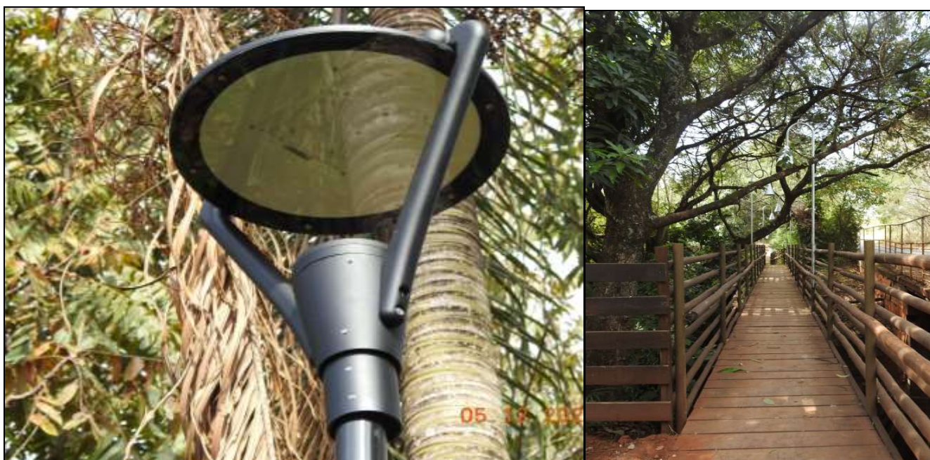
Figura 22 - A direita: detalhe da iluminação e LED instalada em toda a trilha e espaços do parque; a esquerda ponte com iluminação.
