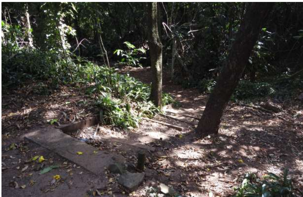
Figura 63 - Escadaria ao longo da trilha que precisa ser melhorada com instalação de corrimão e adequação dos degraus.
