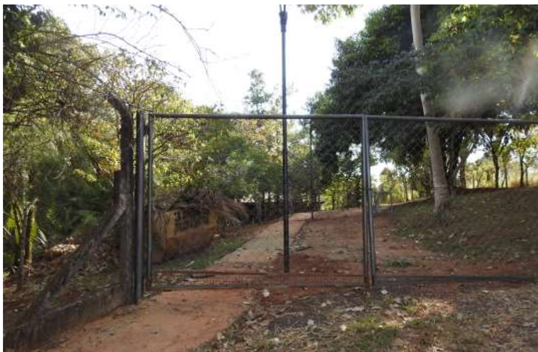
Figura 32 - Entrada destinada a cadeirantes, localizada à Av. São João a direita da entrada principal do parque.
