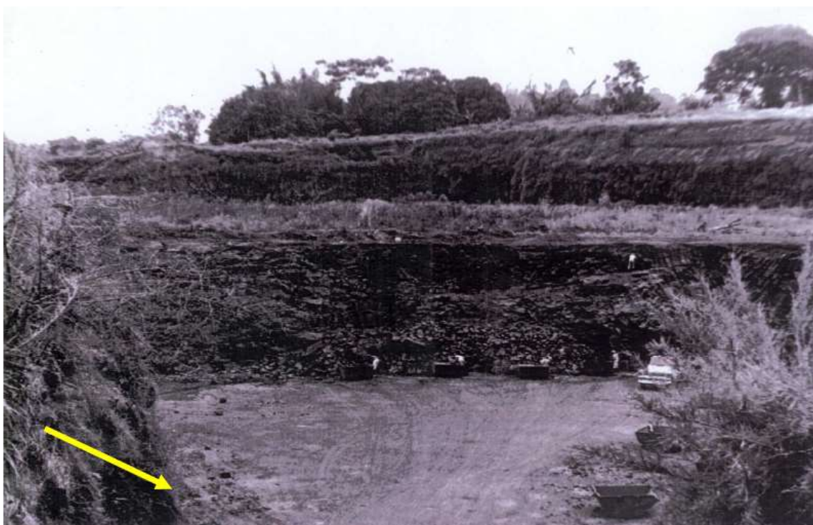
Figura 3. Vista geral da pedreira com homens trabalhando na retirada do basalto com o detalhe do Córrego da Caixa d'Água passando na lateral esquerda (seta) (Fonte: AZZONI, 1967apud CUNHA, 2009).
