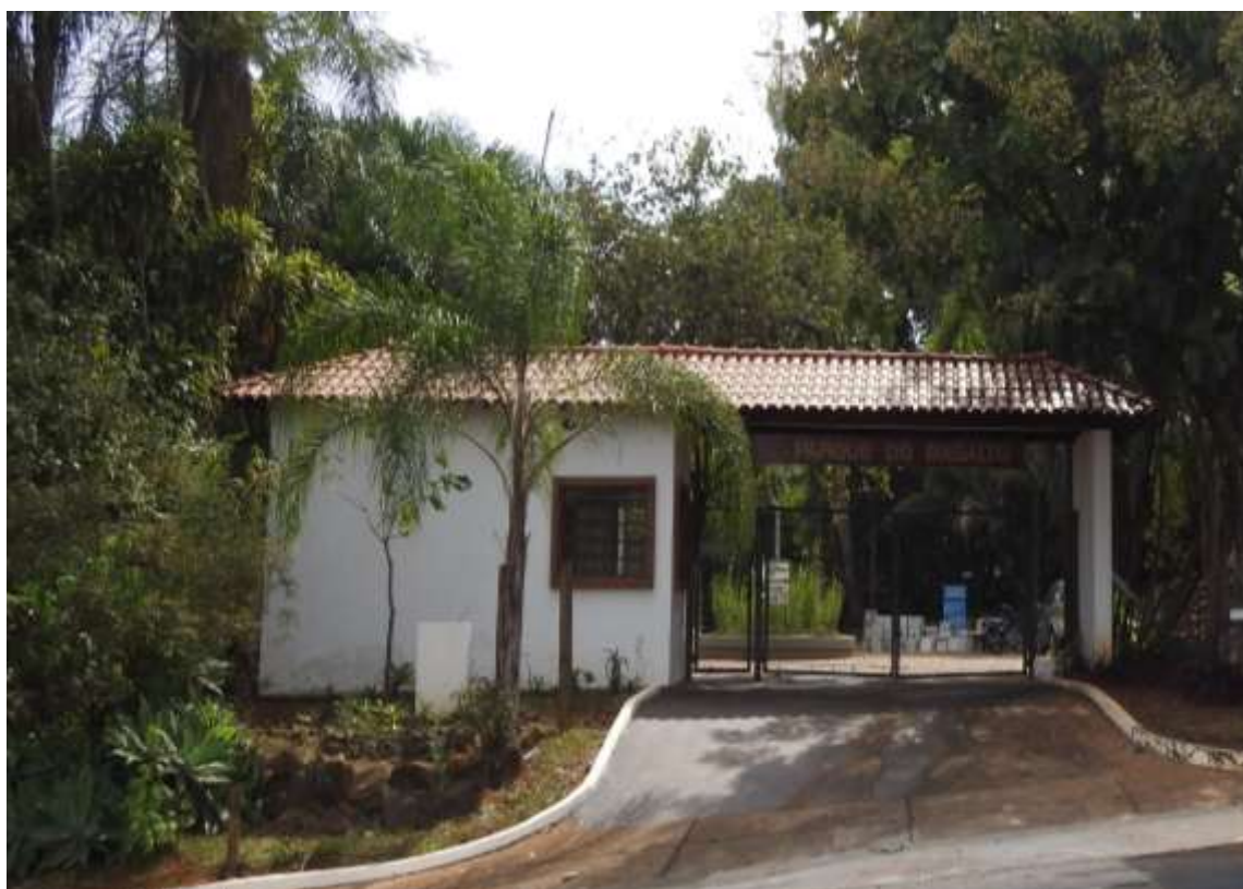
Figura 30 - Guarita e entrada de visitantes.
