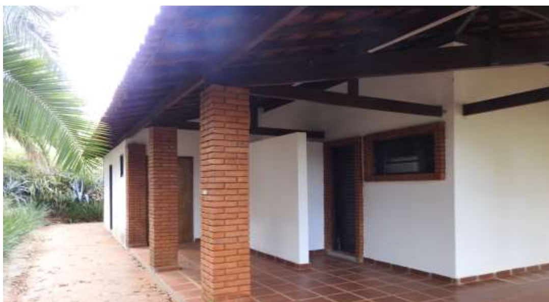
Figura 37 - Banheiros destinados aos visitantes, localizado no Centro de Educação Ambiental.
