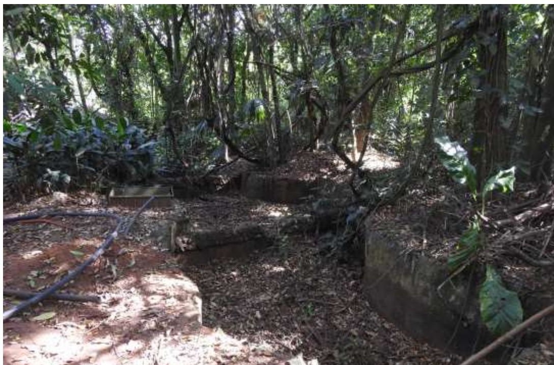
Figura 62 - Local onde passava o extravasamento da represa da propriedade limdeira.
