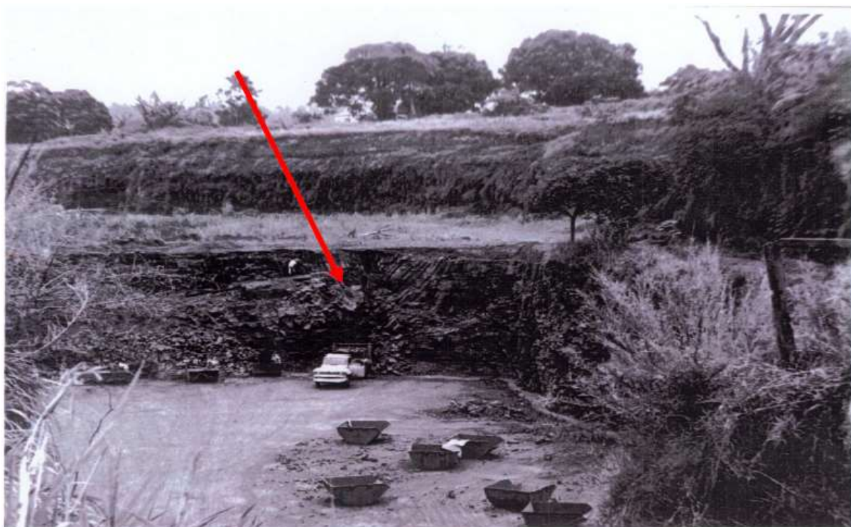
Figura 2. Vista geral do afloramento de basalto (seta) e sua retirada com caçambas. (Fonte: AZZONI, 1967 – apud CUNHA, 2009).
