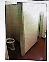
FOTO DO BANHEIRO EXISTENTE 1. REFORMA GERAL COMO ESPECIFICADO ABAIXO
