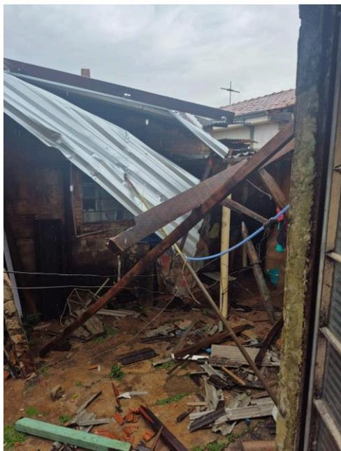
Figura 4 – Queda de telhado
