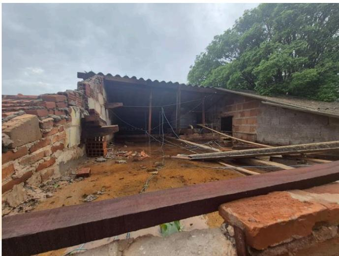
Figura 5 – Destelhamento de residência
