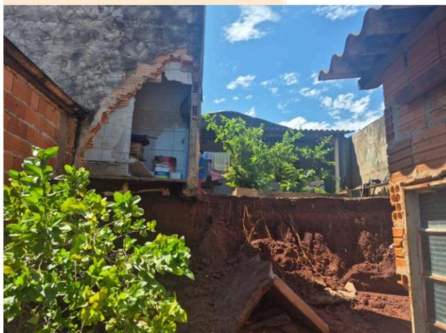
Figura 2 : Desabamento muro e parcial Edícula
