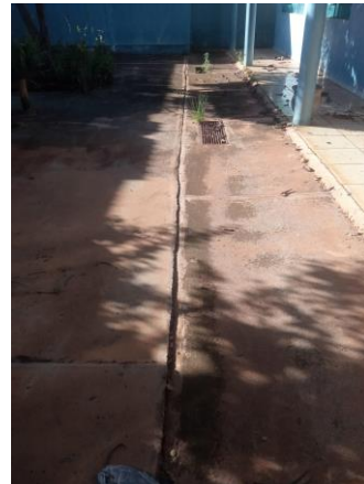
Demolição de piso recalques
