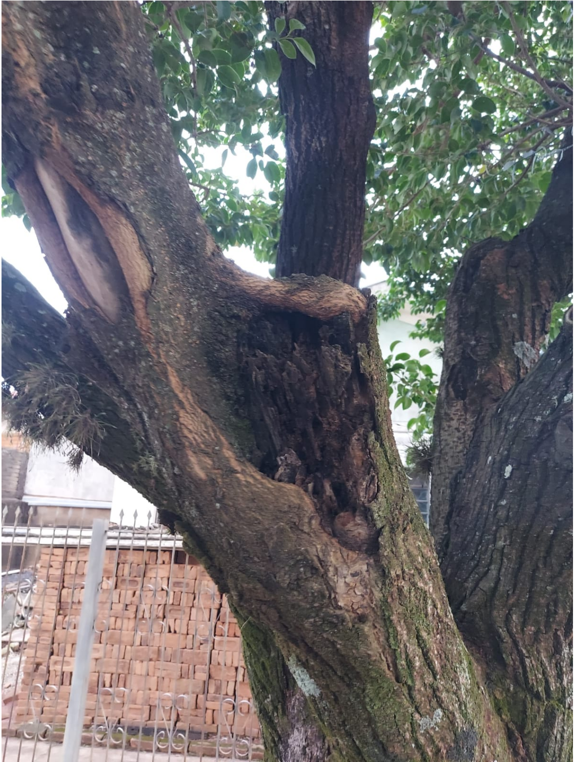
FOTOGRAFIA ÁRVORE OBJETO DO PEDIDO DE REMOÇÃO – PLANTA COMPROMETIDA
