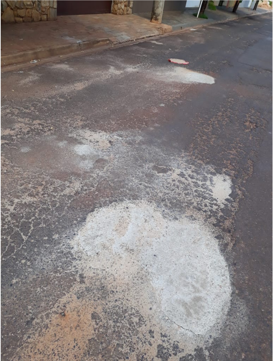
(Diversos buracos sendo cobertos com cimento)
