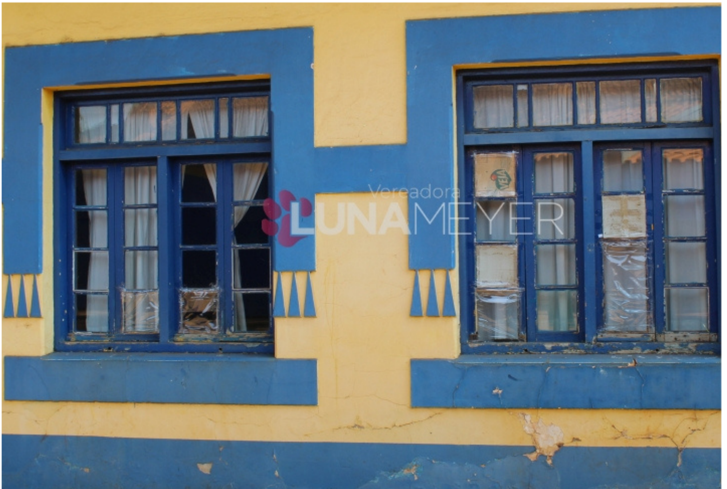
EMEF Hermínio Pagotto - Assentamento Bela Vista
