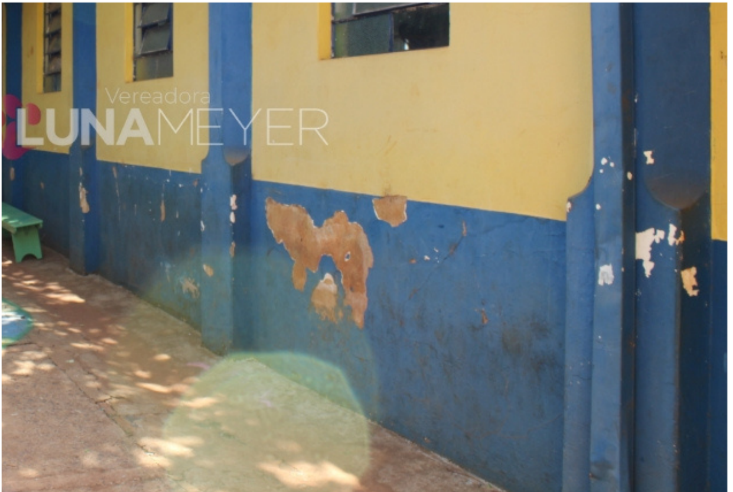
EMEF Hermínio Pagotto - Assentamento Bela Vista
