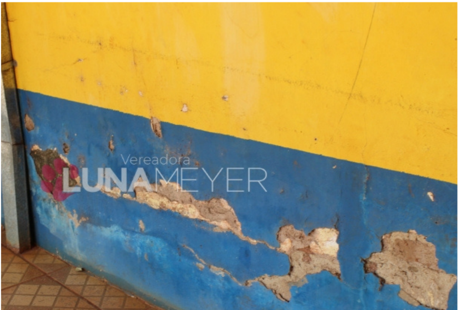
EMEF Hermínio Pagotto - Assentamento Bela Vista
