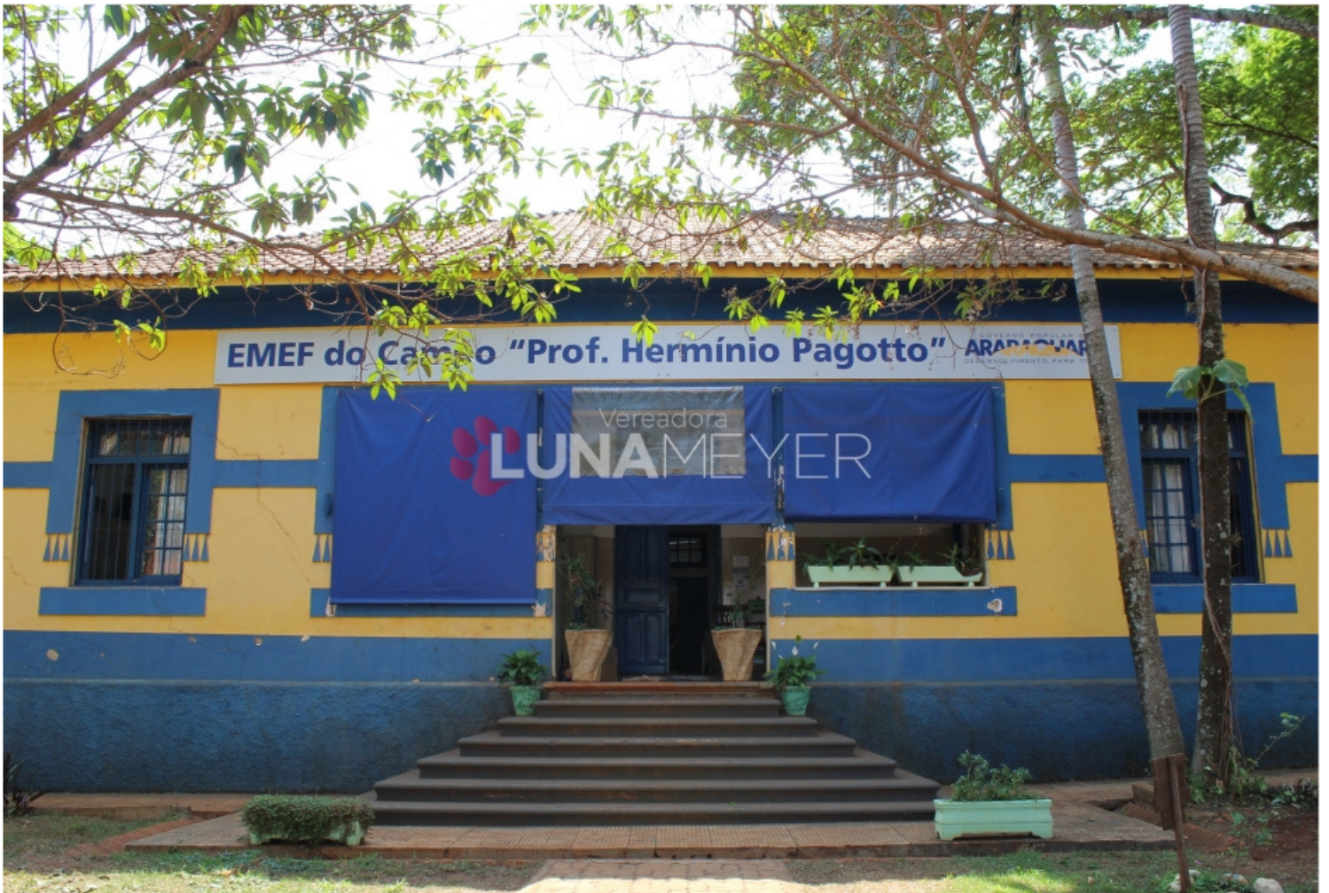
EMEF Hermínio Pagotto - Assentamento Bela Vista
