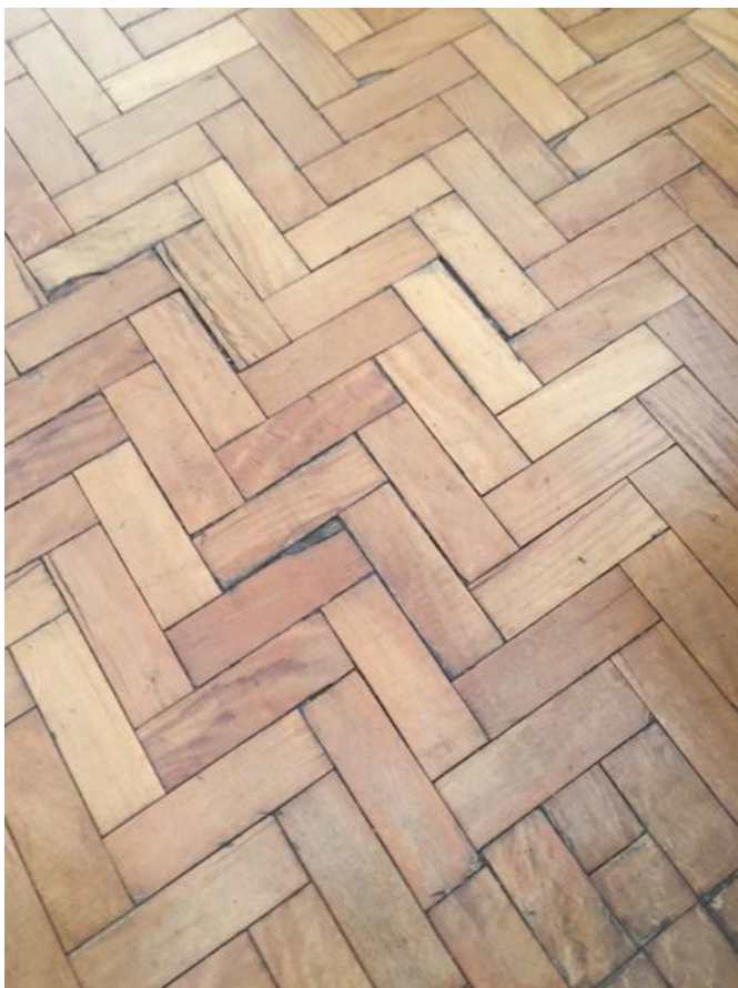
Foto 18 - do piso da Sala 1 – tacos deverão ser removidos e substituídos por piso vinílico, padrão amadeirado ou cimentício, referência marca TARKETT, Linha Ambiente – Design ou Stone, ou similar. Fonte: Alessandra de Lima, 2017.
