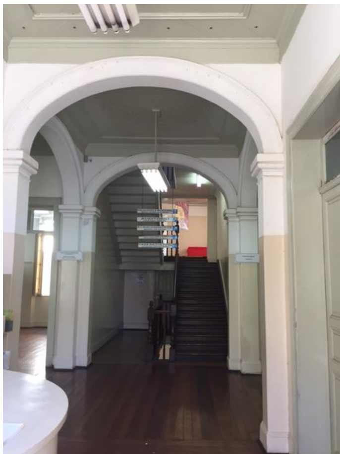
Foto 19 - Hall da entrada principal da Casa da Cultura. Neste projeto de reforma/manutenção as paredes serão pintadas e na altura de 90cm será colocada moldura dividindo a parede em dois tons de tintas a ser escolhido.
