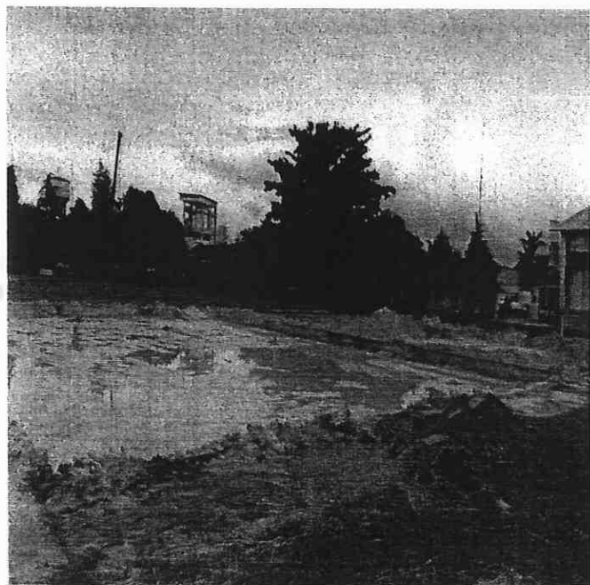
FIGURA 1 – INICIO DAS OBRAS
