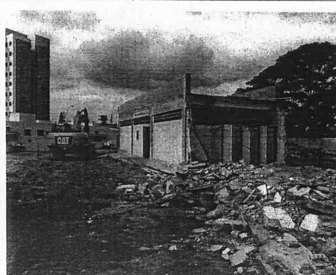
FIGURA – 6 DEMOLIÇÃO MECANIZADA
