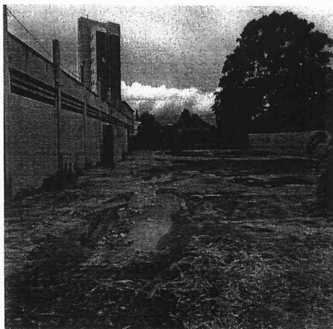
FIGURA – 2 INICIO DAS OBRAS
