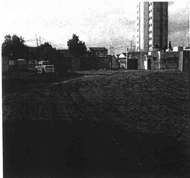
FIGURA – 1 REATERRO, COMPACTAÇÃO E LIMPEZA FINAL
