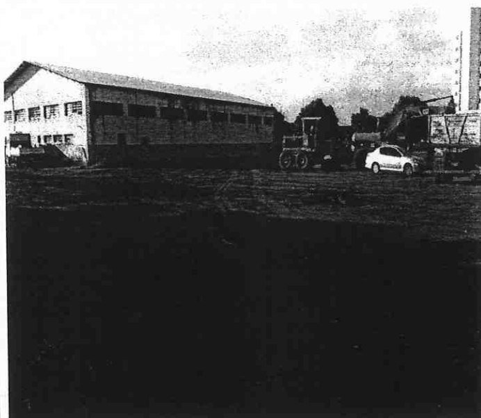
FIGURA – 2 REATERRO, COMPACTAÇÃO E LIMPEZA FINAL
