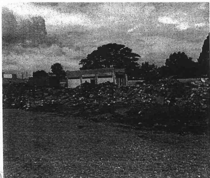
FIGURA – 1 REMOÇÃO DE ENTULHO
