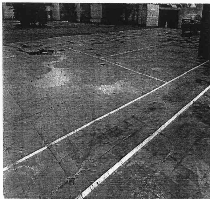
FIGURA 4 – INICIO DAS OBRAS
