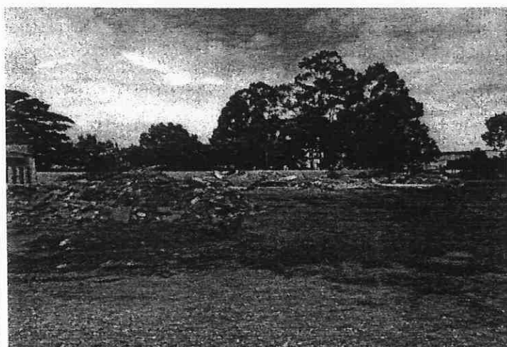
FIGURA – 3 REMOÇÃO DE ENTULHO
