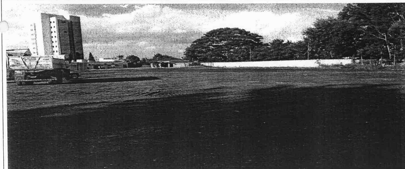
FIGURA – 5 REATERRO, COMPACTAÇÃO E LIMPEZA FINAL
