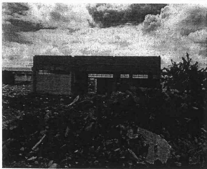
FIGURA – 1 DEMOLIÇÃO MECANIZADA
