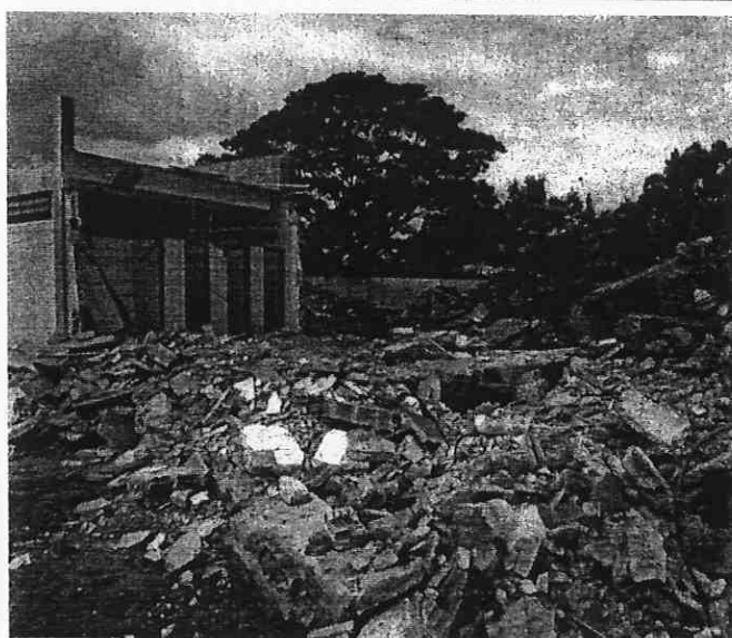
FIGURA – 4 DEMOLIÇÃO MECANIZADA
