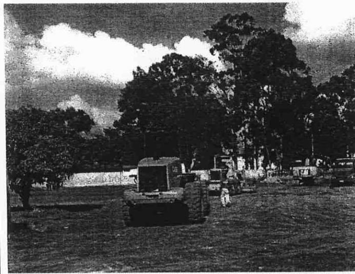
FIGURA – 4 REATERRO, COMPACTAÇÃO E LIMPEZA FINAL
