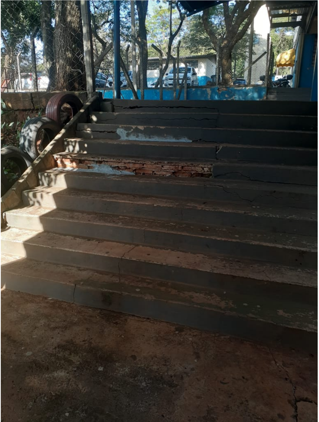
(escada com diversos trincos)
