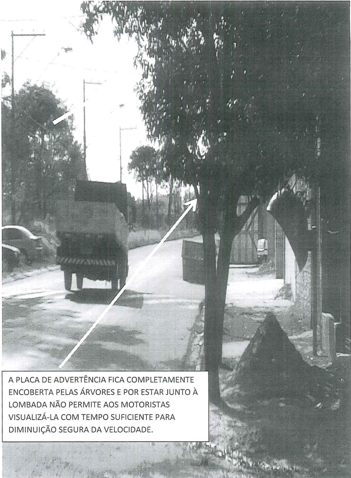
A PLACA DE ADVERTÊNCIA FICA COMPLETAMENTE ENCOBERTA PELAS ÁRVORES E POR ESTAR JUNTO À LOMBADA NÃO PERMITE AOS MOTORISTAS VISUALIZÁ-LA COM TEMPO SUFICIENTE PARA DIMINUIÇÃO SEGURA DA VELOCIDADE.
