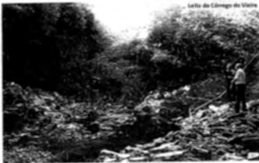
Sugestão para diminuir as águas de superfície: Construir mureta de contenção; Boca de lobo interligada a galeria existente e um ladrão na mureta para direcionar o excesso d'água para uma canaleta superficial.
