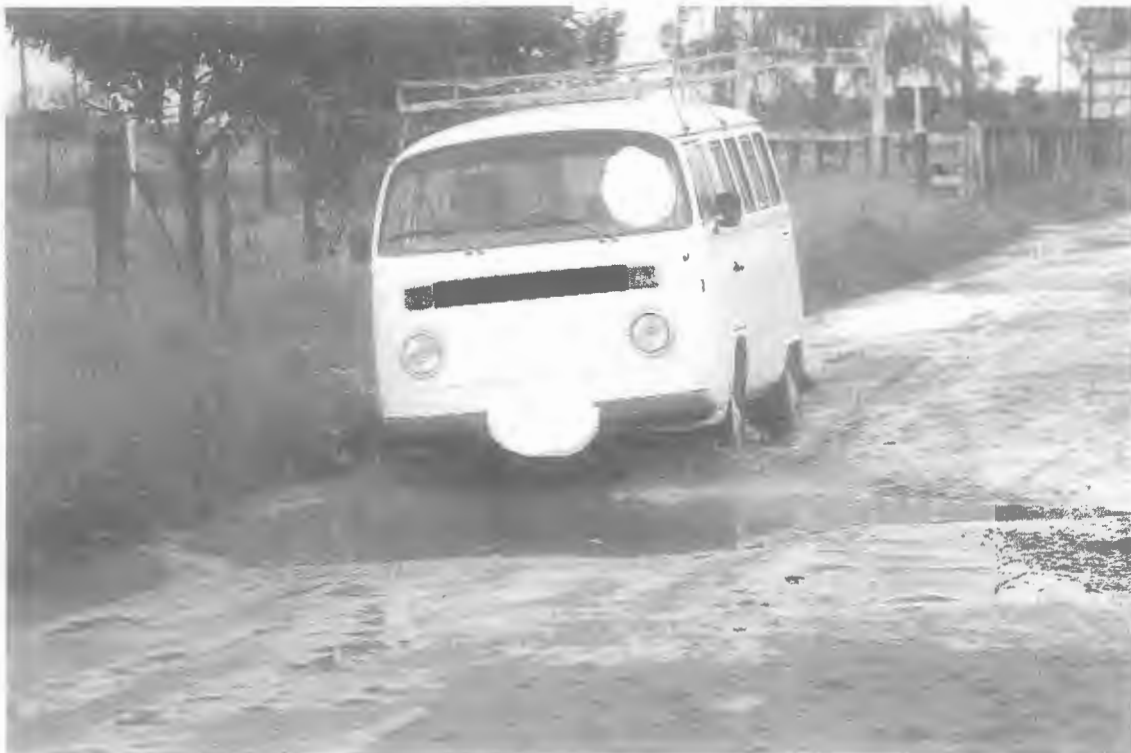
Terraplenagem e regularização na Estrada Assentamento do Horto de Bueno.
