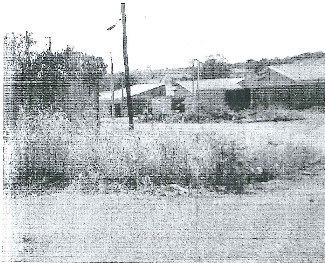
Roçada e a construção da calçada na Avenida Domingos de Nobile cruzamento com a Rua Ângela de Carvalho Martin .
