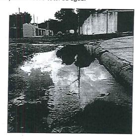
No feriado de carnaval, final de tarde, como havia somente água acumulada, eu dei uma limpada/varrida, até deixar totalmente sem água o local, para tentar mostrar melhor o problema, e podem observar a camada de asfalto que impede a vazão normal da água, parece até um degráu.
