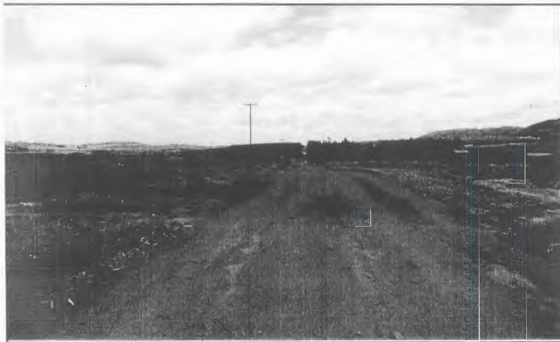
ARA 287 Trecho com pista estreita, irregular, deficiência de drenagem e formação de erosão.
