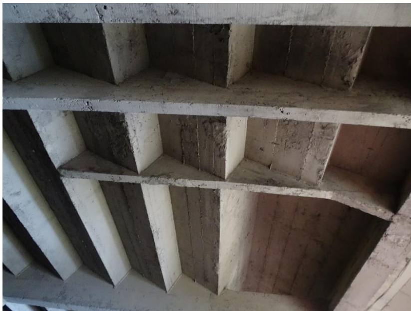
Figura C.163 – Vista inferior do módulo de arquibancada C “Setor 43”. Note a inexistência de anomalias.
