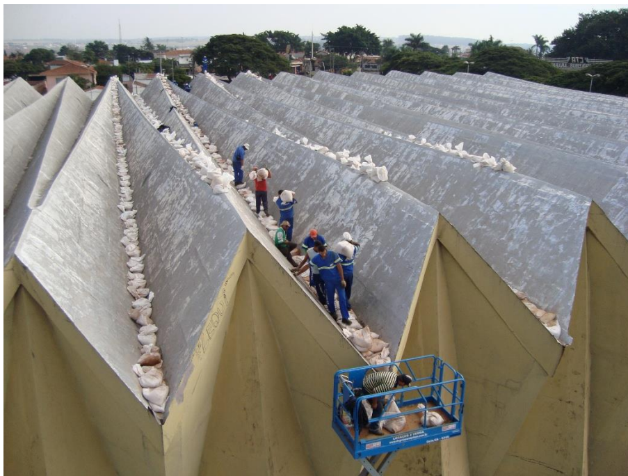
Figura 5 – Carregamento durante a prova de carga.
