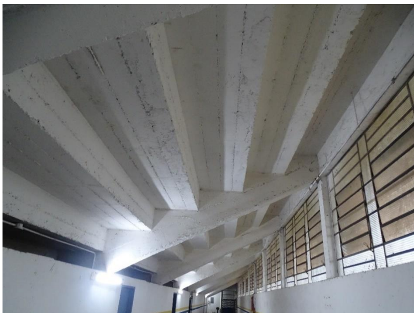
Figura C.152 – Vista inferior do módulo de arquibancada B “Setor 22”. Note a inexistência de anomalias.
