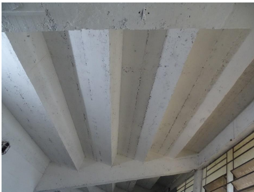
Figura C.148 – Vista inferior do módulo de arquibancada B “Setor 14”. Note a inexistência de anomalias.
