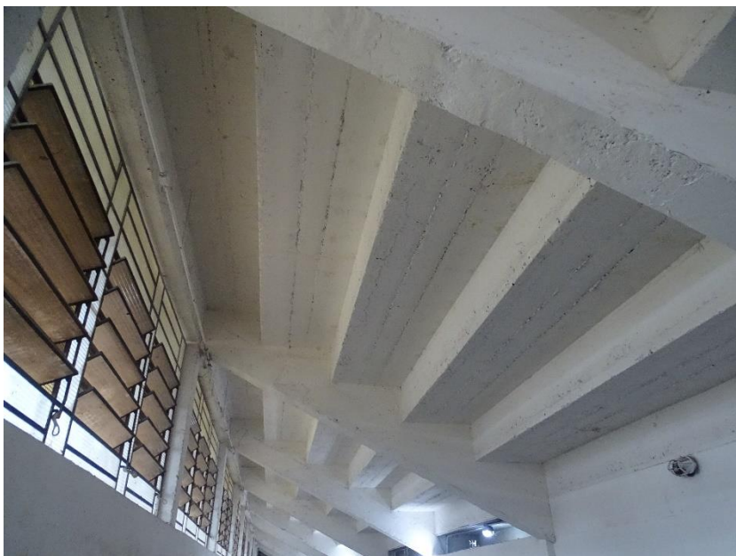
Figura 38 – Vista inferior do módulo de arquibancada B – Setor 16. Observa-se a inexistência de anomalias aparentes.
