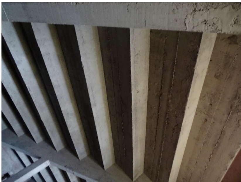
Figura C.164 – Vista inferior do módulo de arquibancada C “Setor 44”. Note a inexistência de anomalias.
