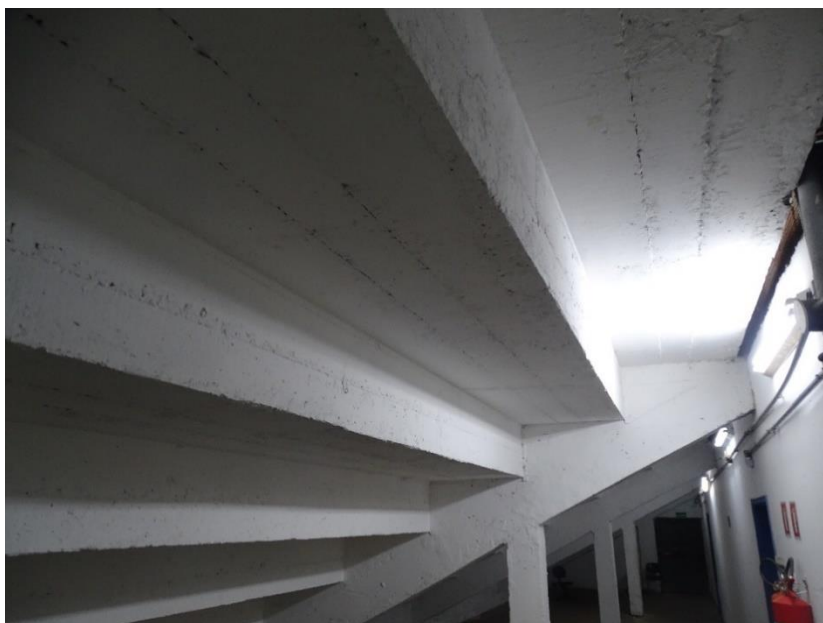
Figura C.146 – Vista inferior do módulo de arquibancada A “Setor 6”. Note a inexistência de anomalias.
