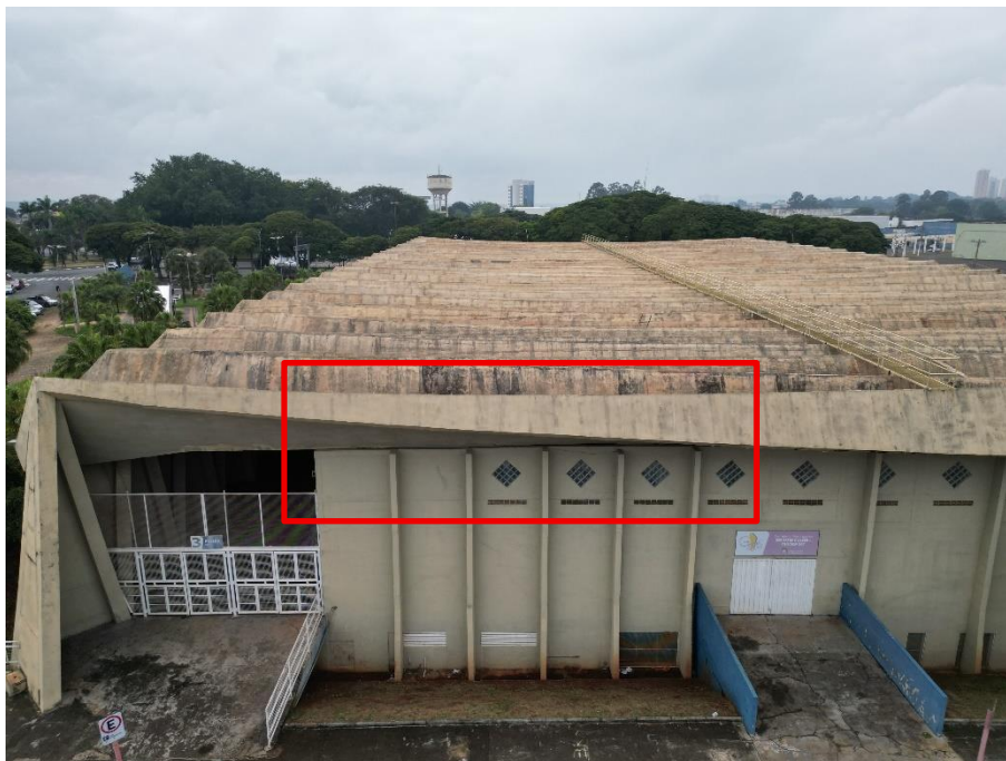
Figura 25 – Vista frontal do ginásio. Detalhe da região de proximidade entre a cobertura e o muro.
