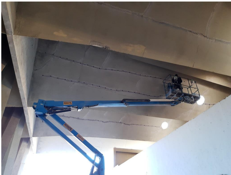
Figura 17 – Injeção de fissuras na região de junta de dilatação na parte inferior da cobertura.
