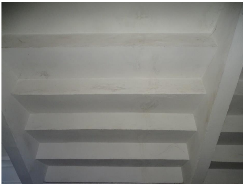
Figura C.155 – Vista inferior do módulo de arquibancada C “Setor 31”. Note a inexistência de anomalias.
