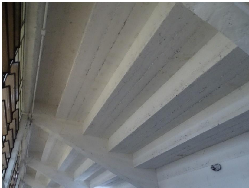
Figura C.151 – Vista inferior do módulo de arquibancada B “Setor 16”. Note a inexistência de anomalias.
