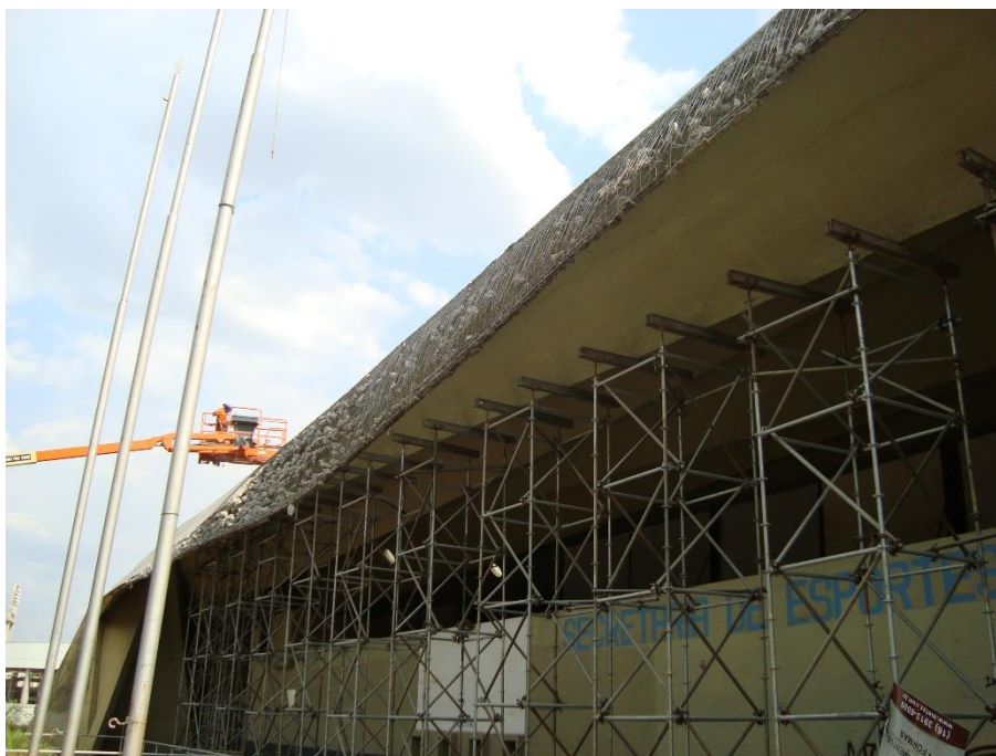
Figura 8 – Demolição da viga elemento 22.
