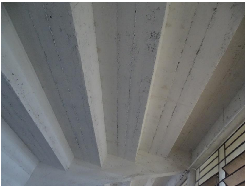
Figura C.149 – Vista inferior do módulo de arquibancada B “Setor 15”. Note a inexistência de anomalias.
