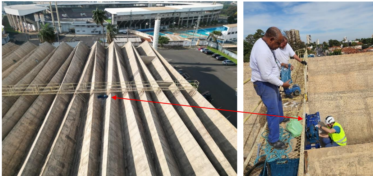
Figura 48 – Instalação do dispositivo mecânico de excitação.
