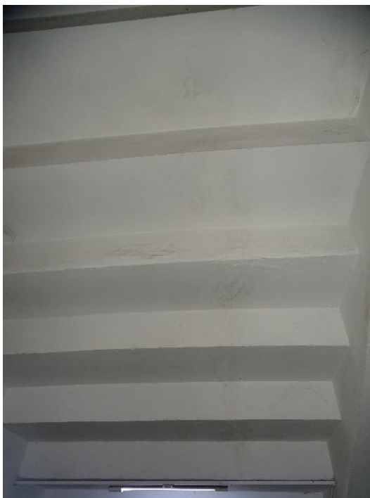
Figura C.154 – Vista inferior do módulo de arquibancada C “Setor 31”. Note a inexistência de anomalias.
