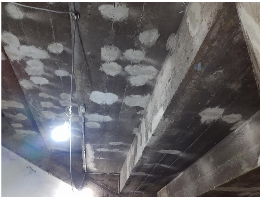
Figura 18 – Reparos na estrutura na região inferior da arquibancada.
