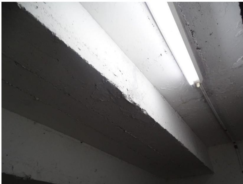
Figura C.147 – Vista inferior do módulo de arquibancada A “Setor 9”. Note a inexistência de anomalias.
