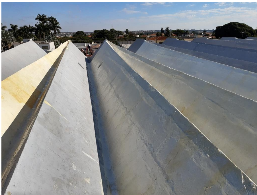
Figura 20 – Execução da impermeabilização em 2021.
