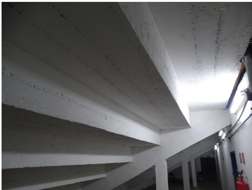
Figura C.153 – Vista inferior do módulo de arquibancada B “Setor 23”. Note a inexistência de anomalias.
