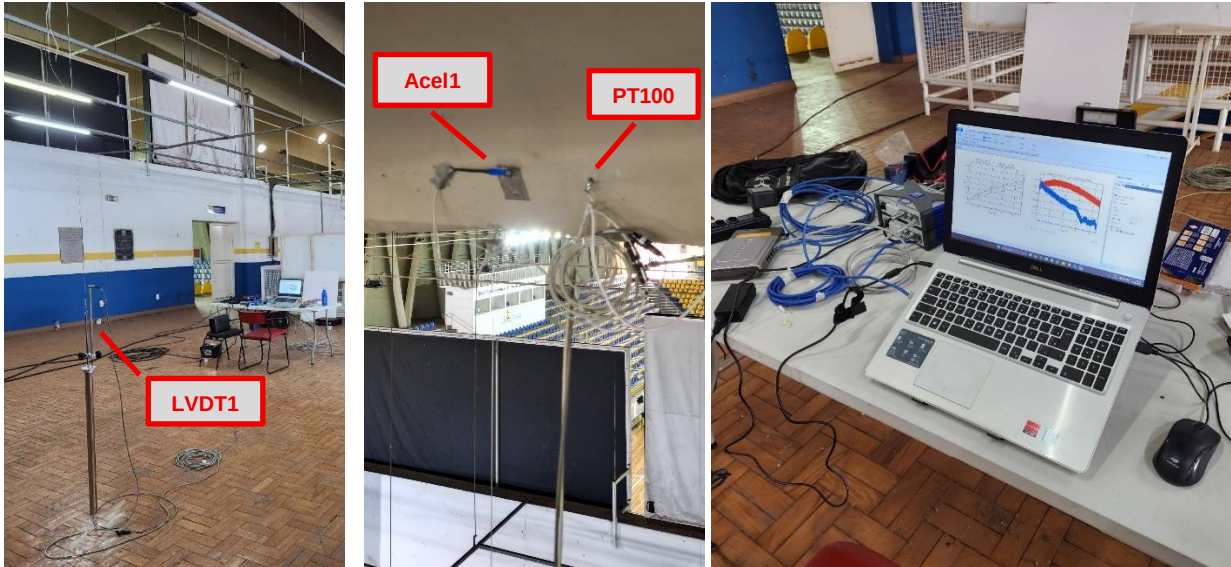
Figura 50 – Sensor LVDT1, Acelerômetro 1, PT100 e Sistema de aquisição.
