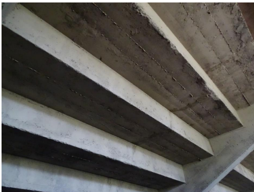
Figura C.160 – Vista inferior do módulo de arquibancada D “Setor 38”. Note a inexistência de anomalias.
