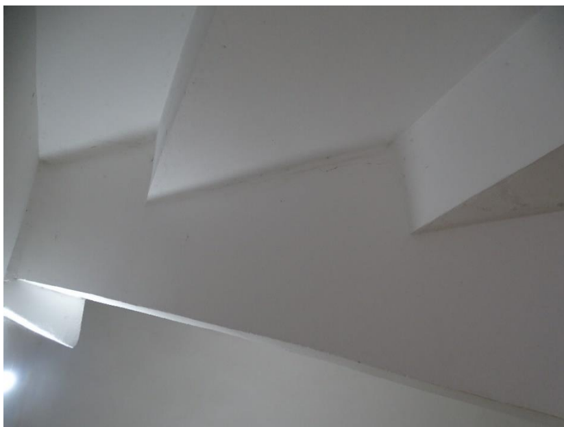
Figura C.158 – Vista inferior do módulo de arquibancada C “Setor 34”. Note a inexistência de anomalias.
