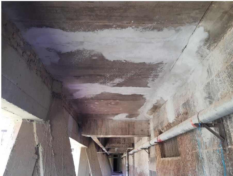
Figura 19 – Reparos na estrutura próximo aos pilares.
