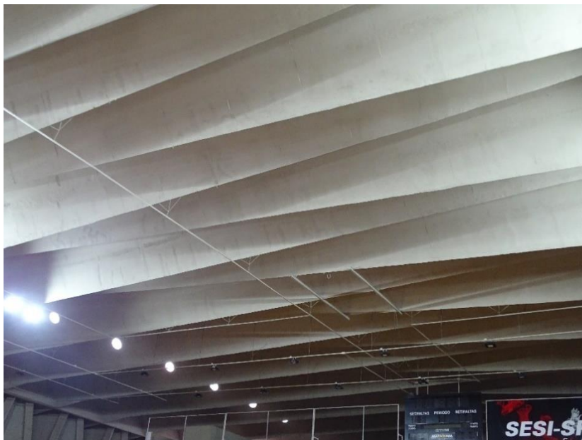
Figura C.143 – Vista geral da cobertura. Note fissuras reparadas sem indícios de evolução de abertura, nem manchas de umidade.
