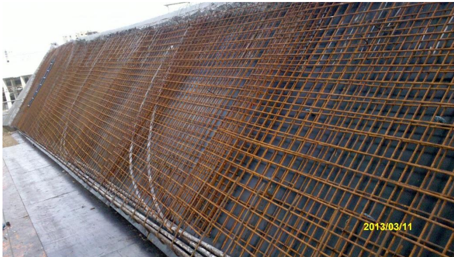
Figura 10 – Armação da viga elemento 22.
