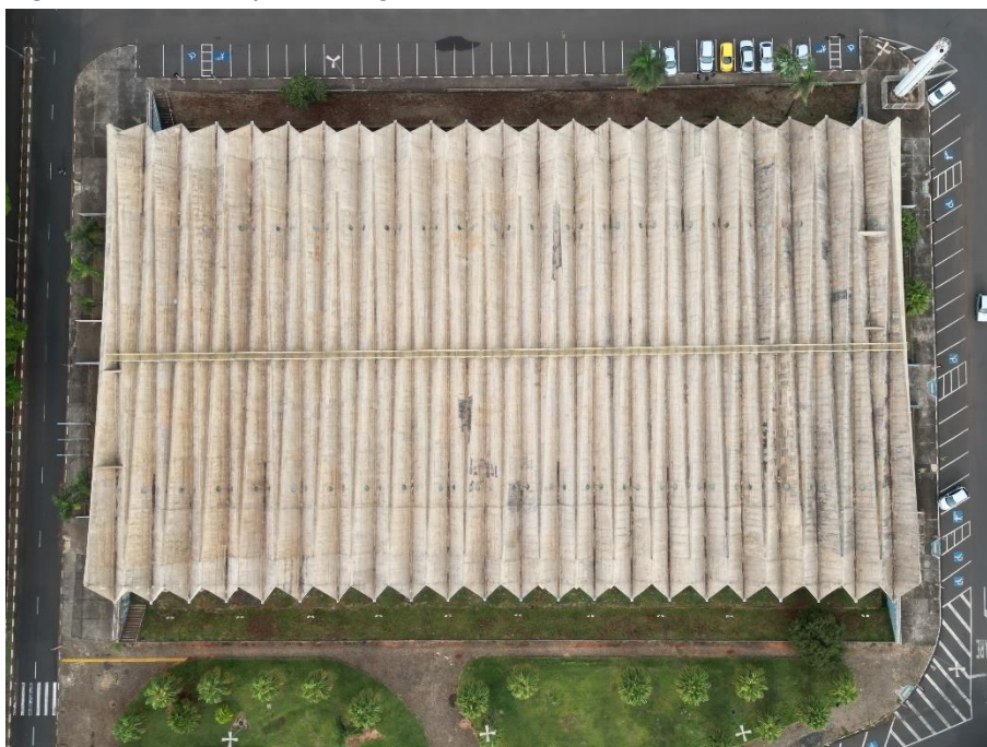
Figura 2 – Vista superior do ginásio.
