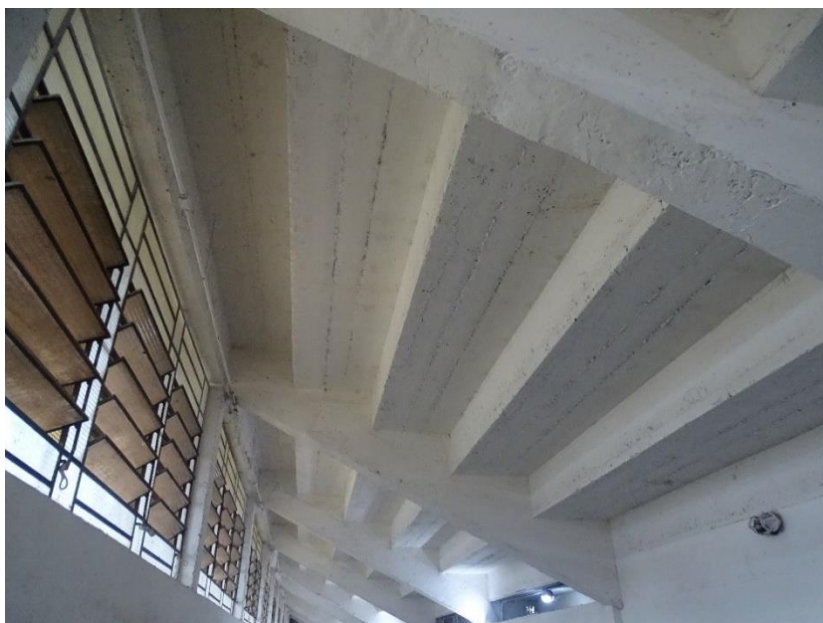
Figura C.150 – Vista inferior do módulo de arquibancada B “Setor 16”. Note a inexistência de anomalias.
