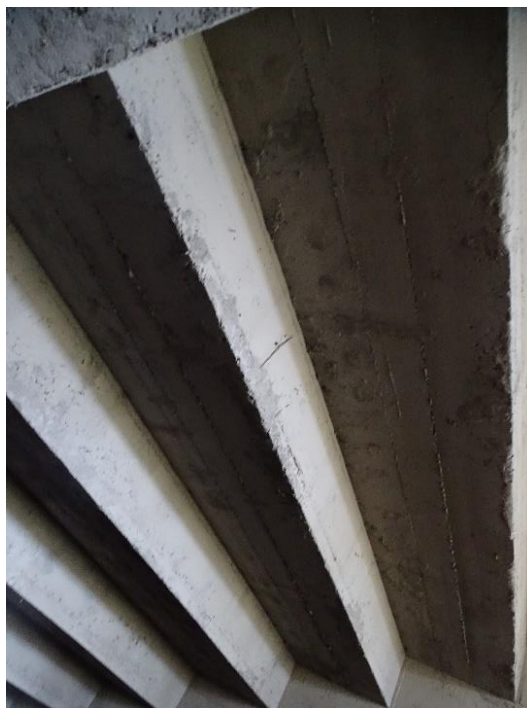
Figura C.162 – Vista inferior do módulo de arquibancada C “Setor 42”. Note a inexistência de anomalias.
