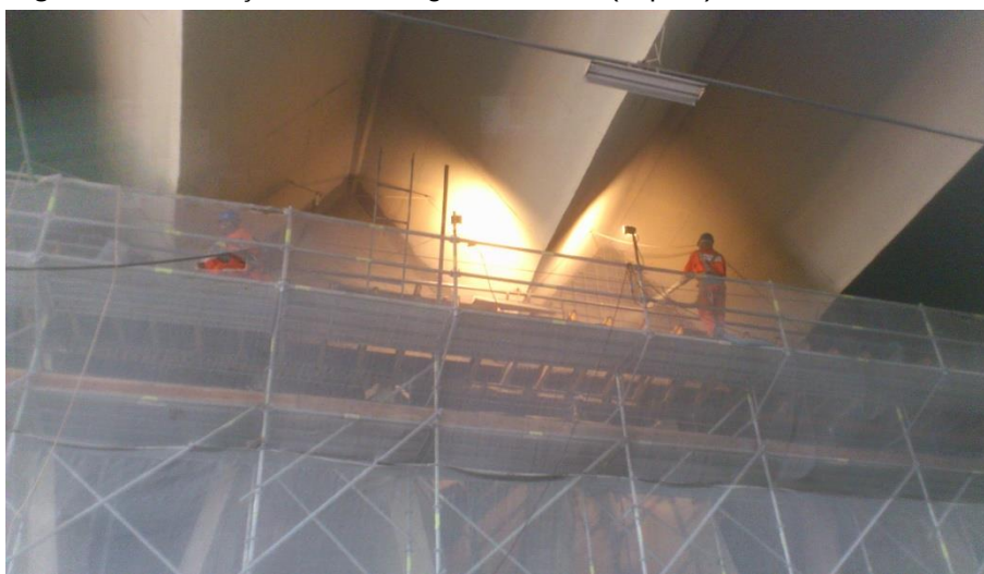
Figura 13 – Reforços entre as vigas elemento (septos).
