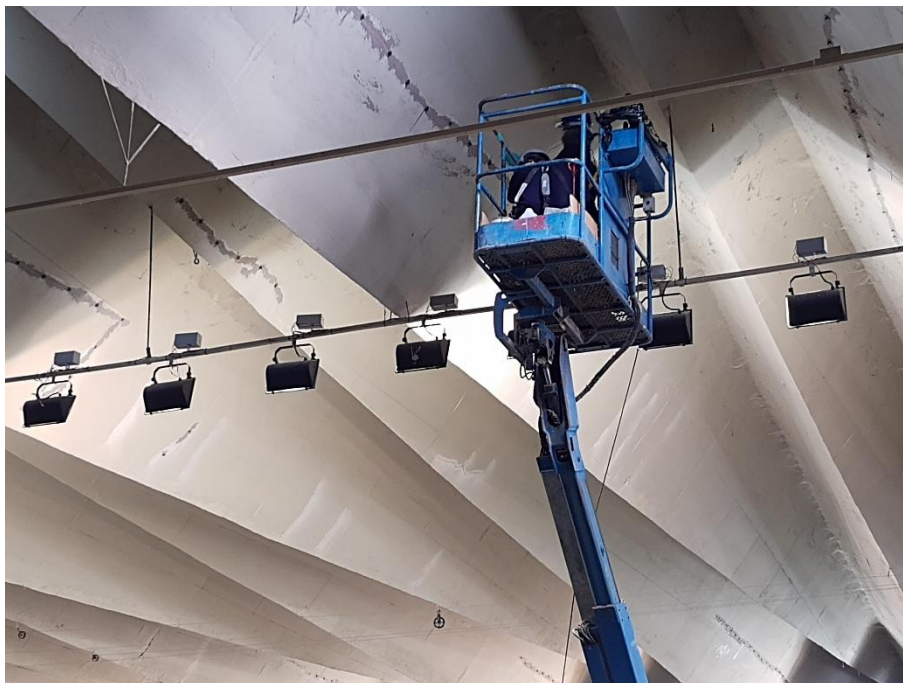
Figura 15 – Injeção de fissuras na região de junta de dilatação na parte inferior da cobertura.
