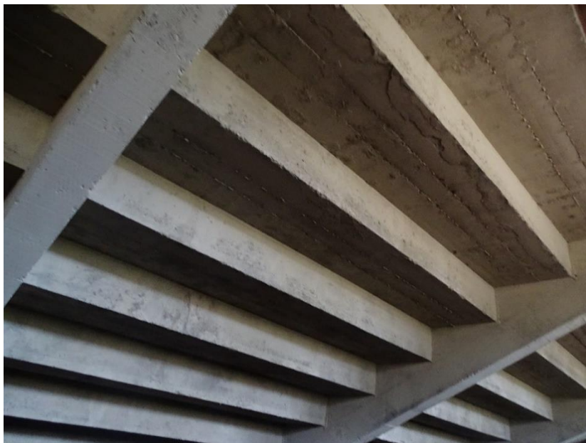
Figura C.165 – Vista inferior do módulo de arquibancada C “Setor 45”. Note a inexistência de anomalias.
