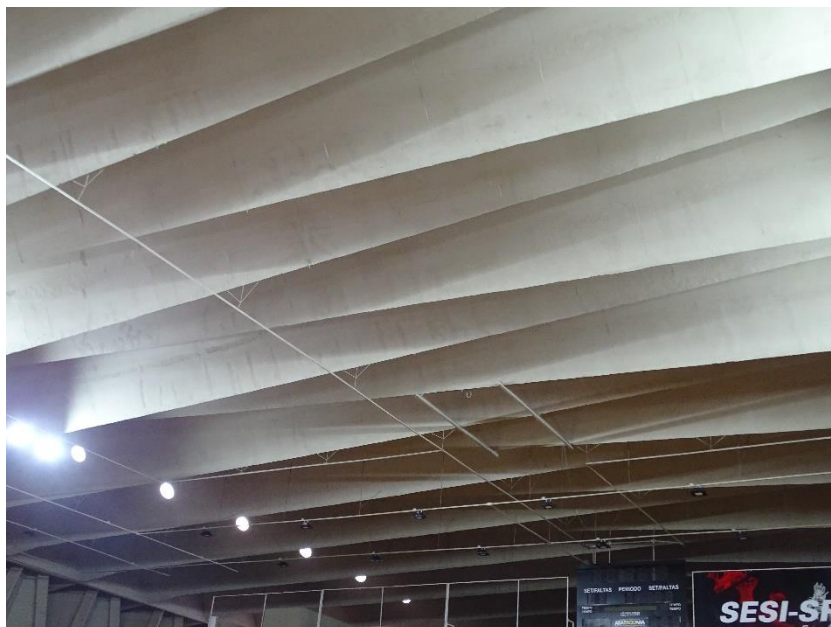
Figura 36 – Vista geral da face inferior da cobertura. Note que não há indícios de manchas de umidade nas fissuras reparadas.
