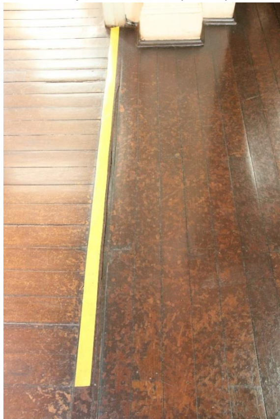
Foto 38 - Degrau da escada e piso 1º pavimento.
