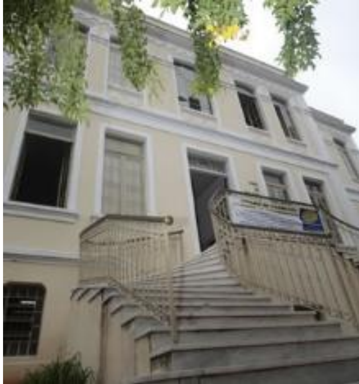
Foto 01 - da fachada principal – Rua São Bento.
