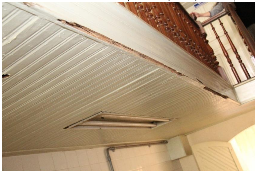
Foto 12 - do Forro do Térreo / embaixo piso 1º pavimento /
