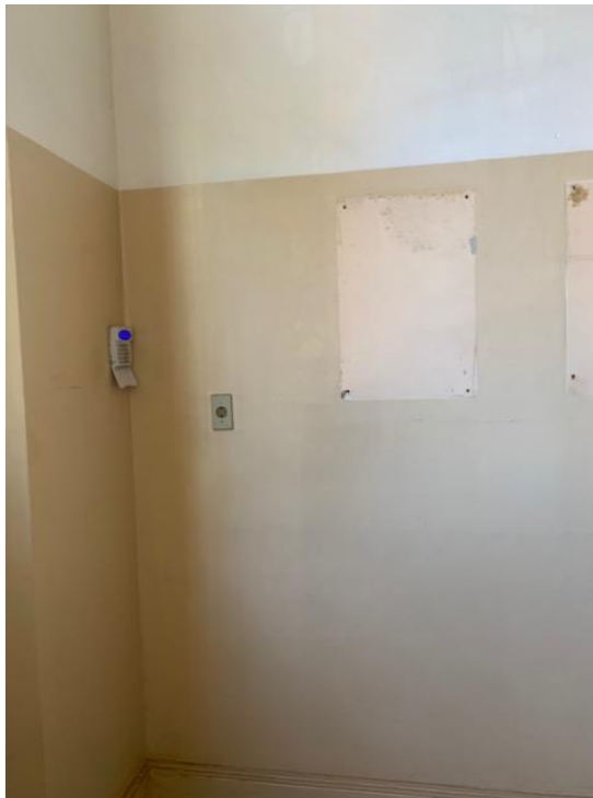
Foto 02. Interna. Hall– fica no 1º pavimento
