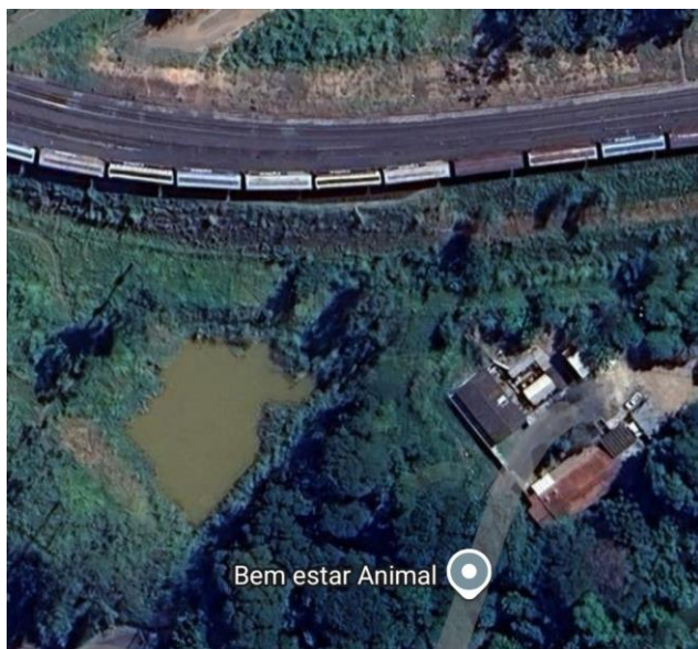
Figura 06 – Bacia de Contenção de águas pluviais
