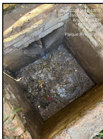
Figuras 30 e 31 – caixa de passagem em concreto, onde se acumulam os dejetos provenientes das baias dos animais. Esses dejetos passam a se decompor inadequadamente.
