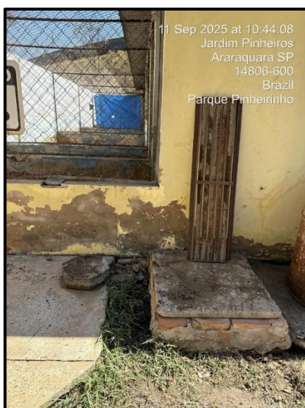
Figuras 30 e 31 – caixa de passagem em concreto, onde se acumulam os dejetos provenientes das baias dos animais. Esses dejetos passam a se decompor inadequadamente.
