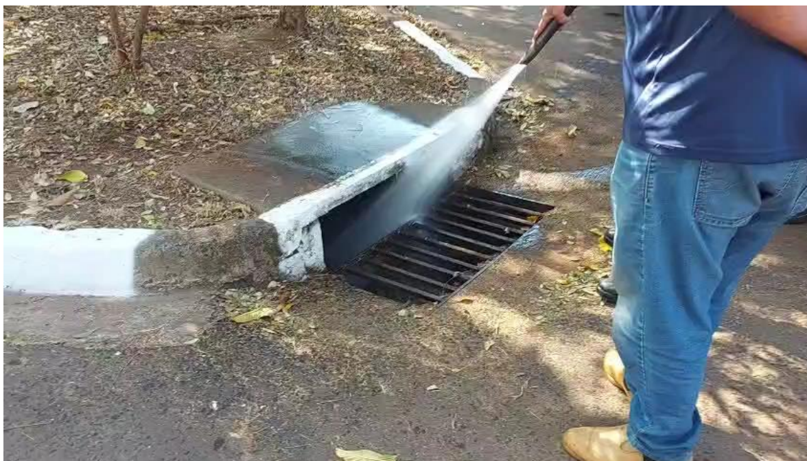
Figura 02 – Teste com cal e água nos 03 bueiros que levam água para represa dos peixes
