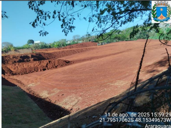
OBRAS DE TERRAPLANAGEM
