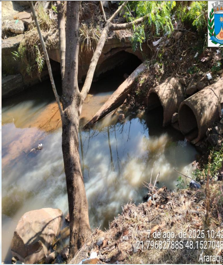
DUTO HIDRÁULICO DE CONCRETO LADO ESQUERDO
