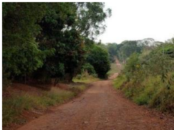
Figura 10 – Rua Vereador Mario Ananias (trecho não asfaltado). Fonte: Pacaembu Construtora.
