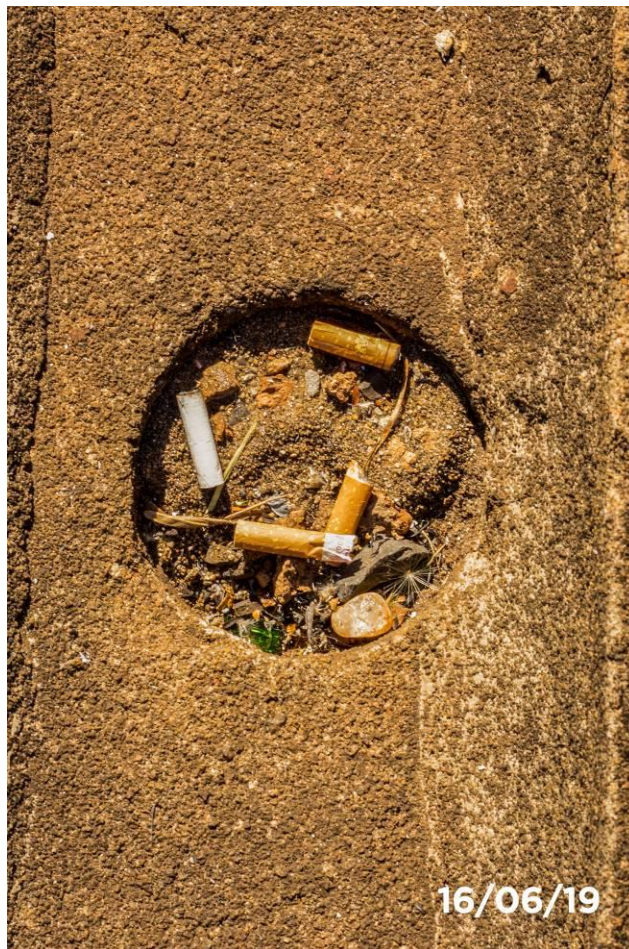
Foto 11 – Detalhe ponto de queda d'água obstruída por resíduos sólidos urbanos, e vegetação.
