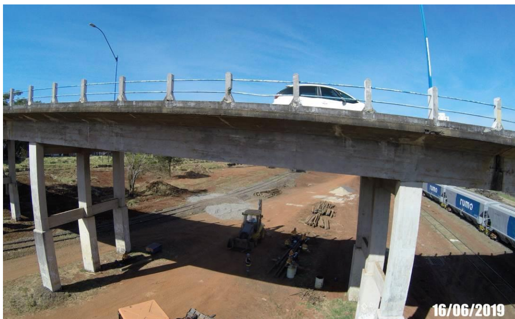
Foto 37: Vista da viga principal com infiltração na junta, eflorescência e deslocamento de concreto. E guarda corpo amassado.
