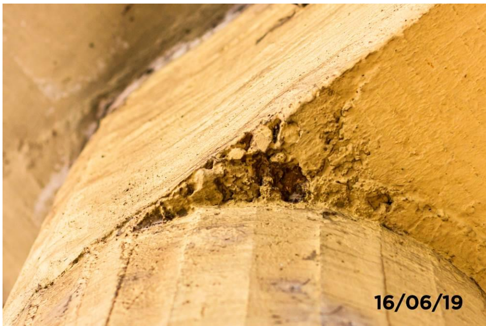
Foto 38: Detalhe do ponto isolado de destacamento do concreto no topo do pilar.
