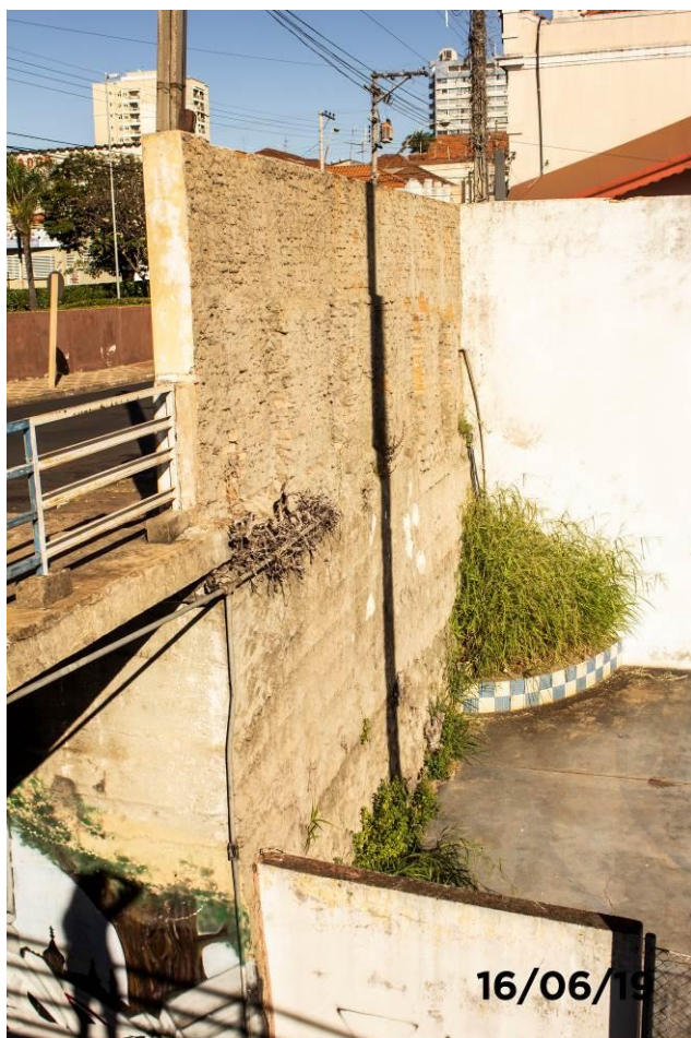
Foto 45: Detalhe da vegetação no muro de arrimo.
