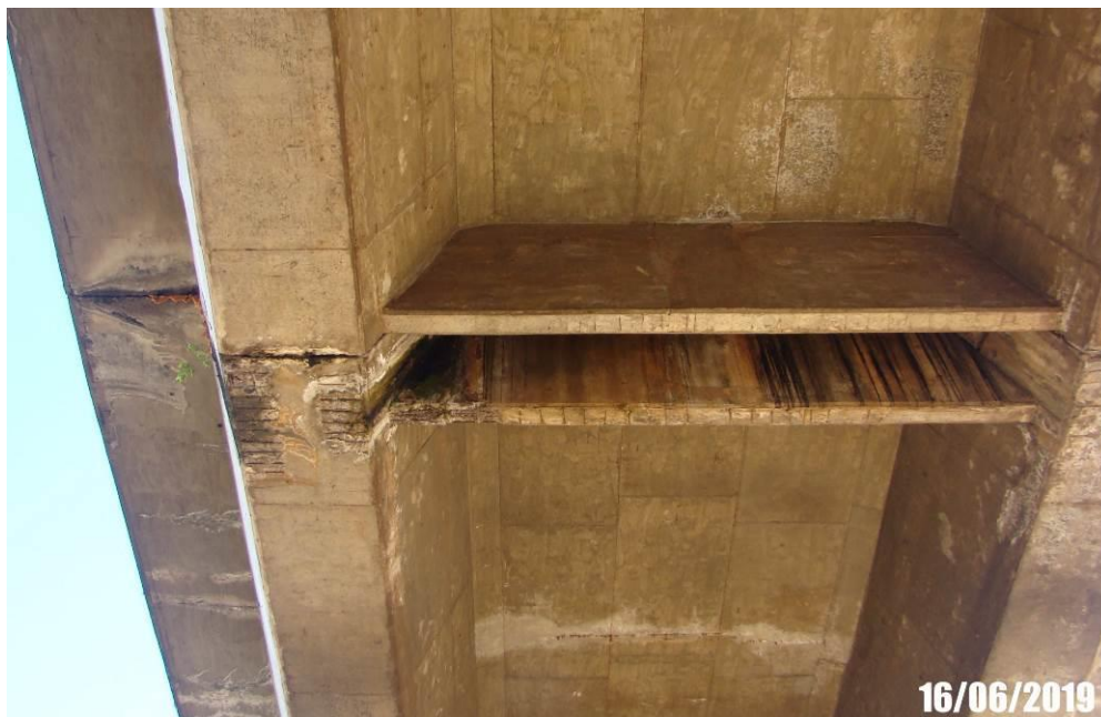
Foto 44: Detalhe da face inferior do tabuleiro com armadura exposta e infiltração, devido a patologia na junta de dilatação.
