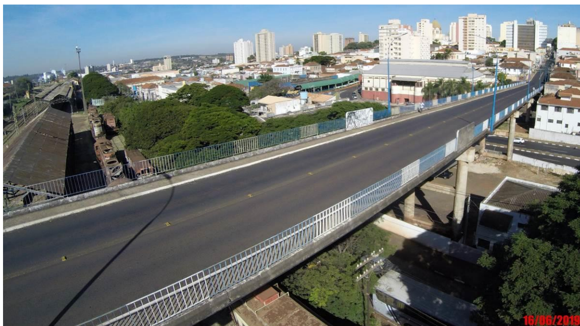
Foto 01: Vista geral da face superior do tabuleiro.
