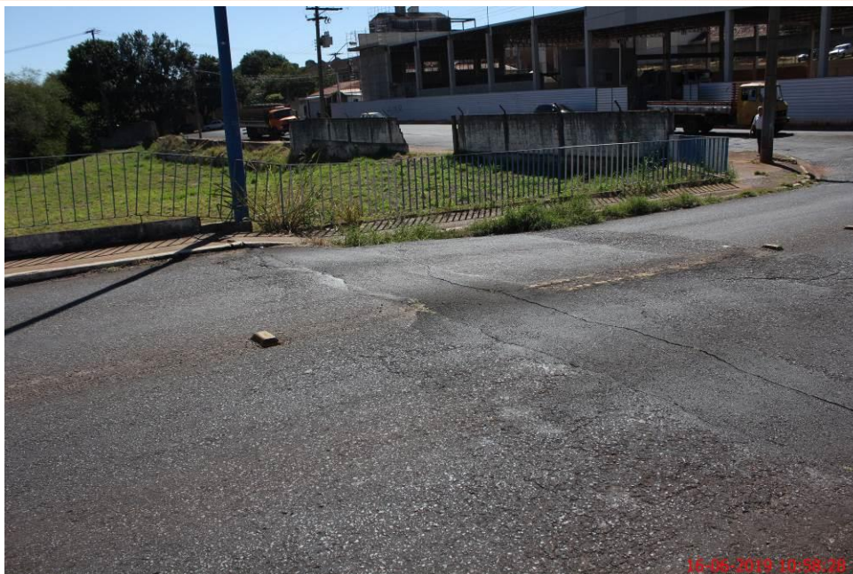
Foto 10: Detalhe do encontro entre o pontilhão e a via com a junta coberta pelo pavimento flexível.
