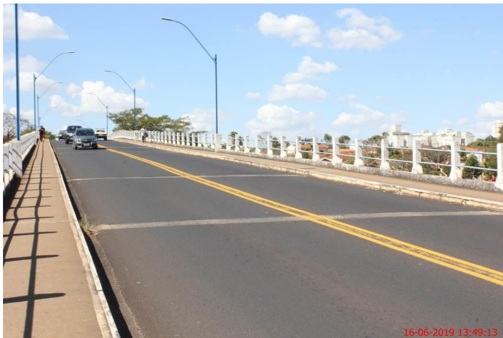
Foto 28: Vista de iluminação sobre o tabuleiro.
