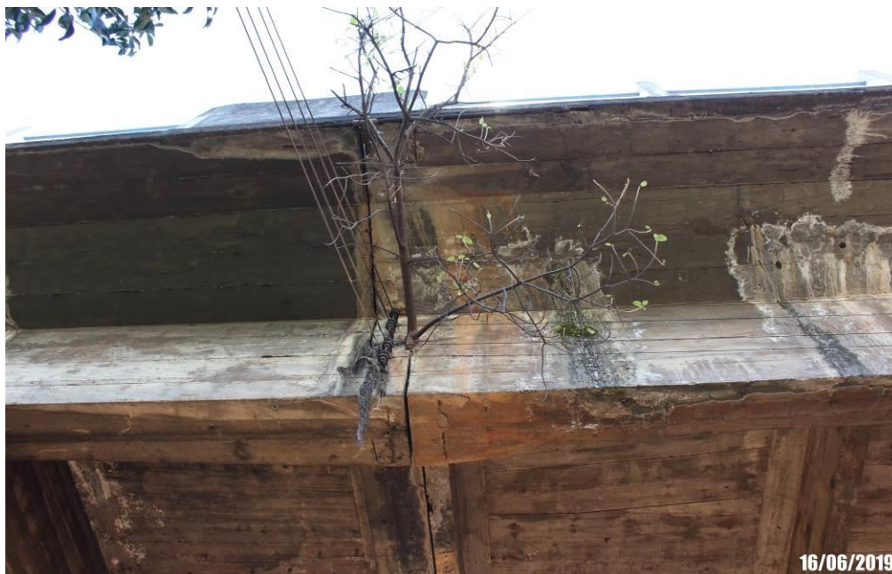
Foto 39: Detalhe da viga principal com vegetação, infiltração, eflorescência, deslocamento de concreto na viga principal.
