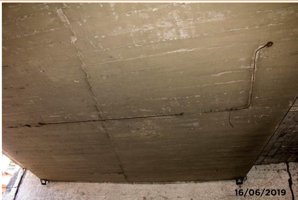
Foto 23: Detalhe da face inferior do tabuleiro com presença de deslocamento de concreto e tubulação de elétrica rompida. Ao fundo vê-se a instalação elétrica em funcionamento.
