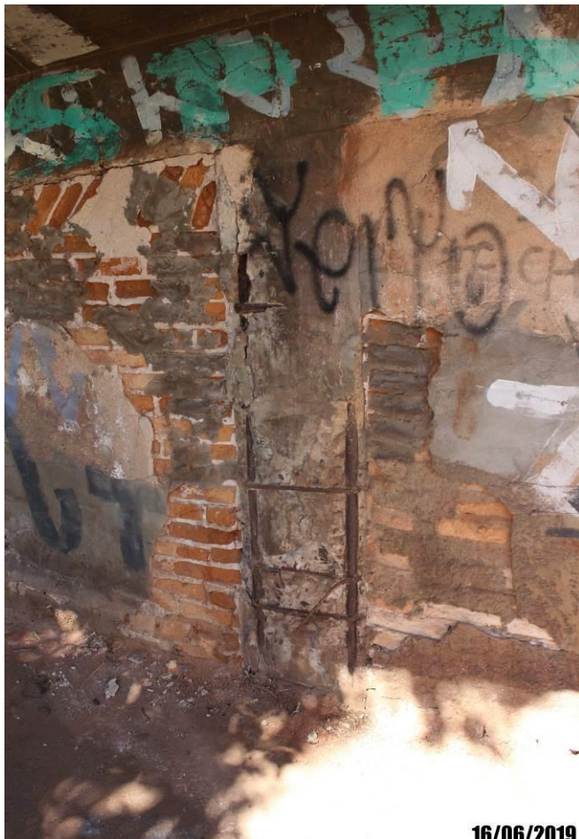
Foto 63: Detalhe de armadura exposta do muro ala.
