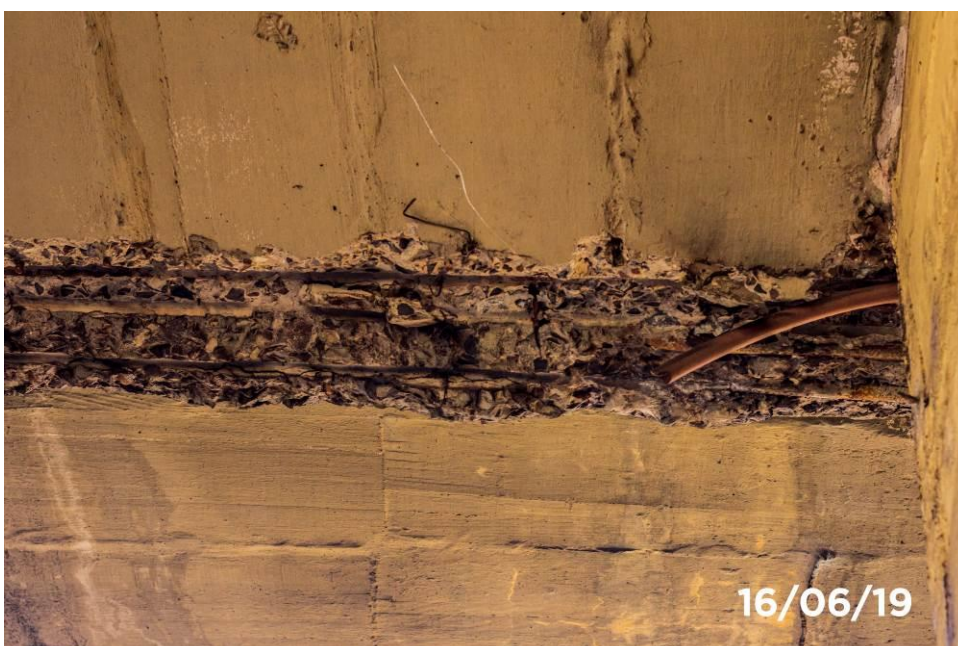
Foto 33: Detalhe de dutos rompidos.
