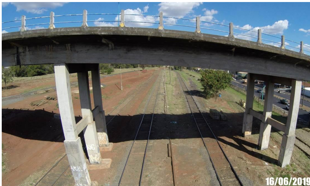
Foto 43: Vista da face lateral da viga com infiltração, eflorescência e deslocamento de concreto.
