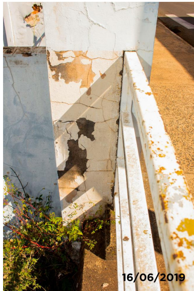
Foto 20: Detalhe de vegetação e fissura na parede de apoio do guarda corpo. E é visível também forte ponto de corrosão.
