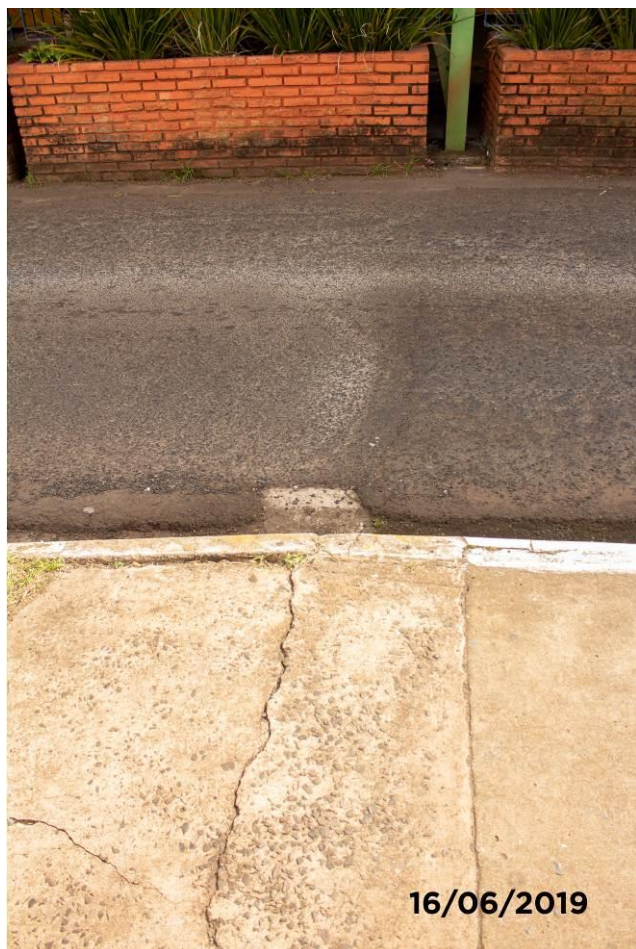
Foto 07: Vista da fissura no pavimento asfáltico e no passeio entre o encontro do viaduto e a via.
