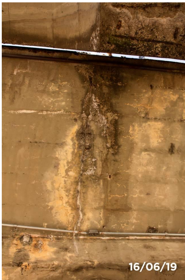
Foto 31: Detalhe da fissura gerando infiltração e eflorescência no encontro com a passarela.
