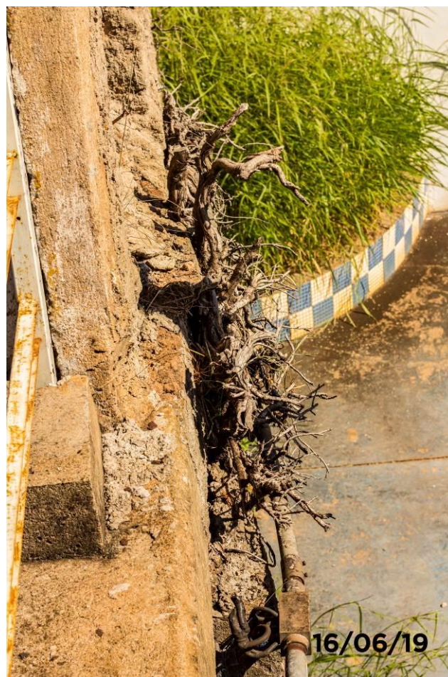
Foto 46: Detalhe da vegetação no muro de arrimo.
