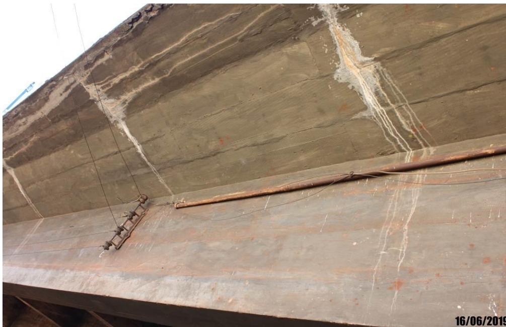
Foto 31: Detalhe de oxidação na tubulação de energia elétrica e fixação na viga principal de ponto de distribuição de energia elétrica.
