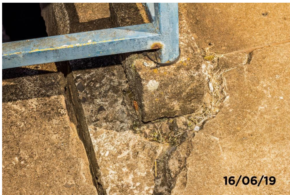
Foto 06- Destacamento do concreto do Passeio e bloco de fixação da guarda corpo.
