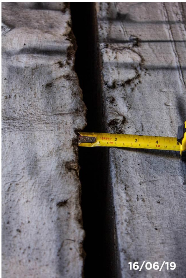
Foto 41: Detalhe da dilatação no muro de arrimo.
