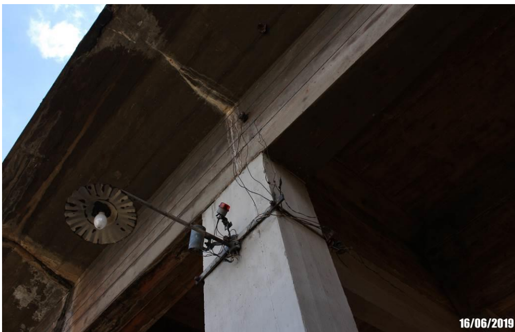
Foto 32: Detalhe de ponto de energia elétrica com instalação não condizente com a norma NBR 5410.
