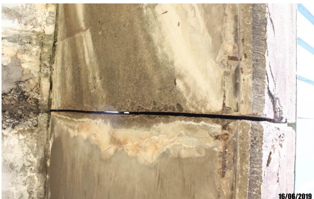
Foto 33: Detalhe de armadura exposta na pingadeira e infiltração com eflorescência na junta de dilatação da calçada.
