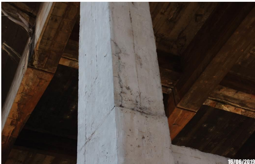
Foto 70: Detalhe de deslocamento de concreto.
