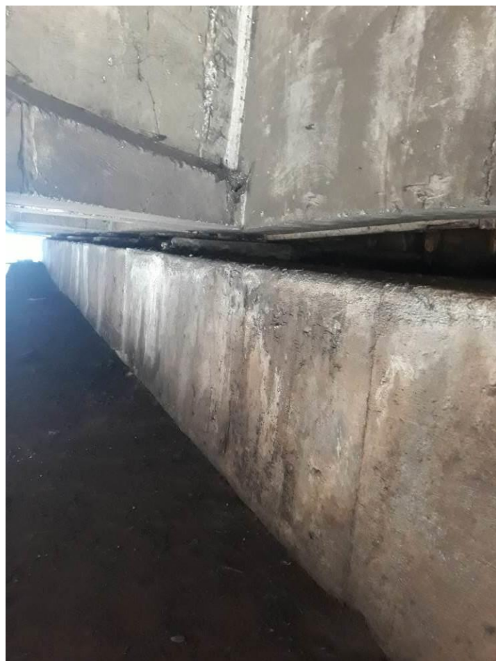
Foto 39: Detalhes dos neoprenes das extremidades, com os apoios apresentando deslocamento de concreto.
