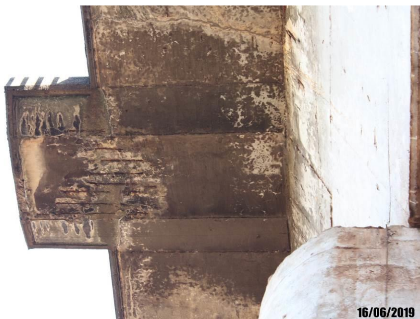
Foto 36: Detalhe de armadura exposta na face inferior do tabuleiro, lateral da viga principal e fissura na face inferior do tabuleiro.
