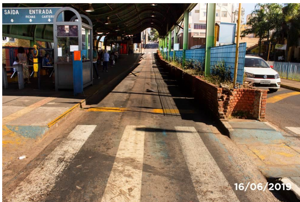
Foto 01: Vista da face superior do tabuleiro.
