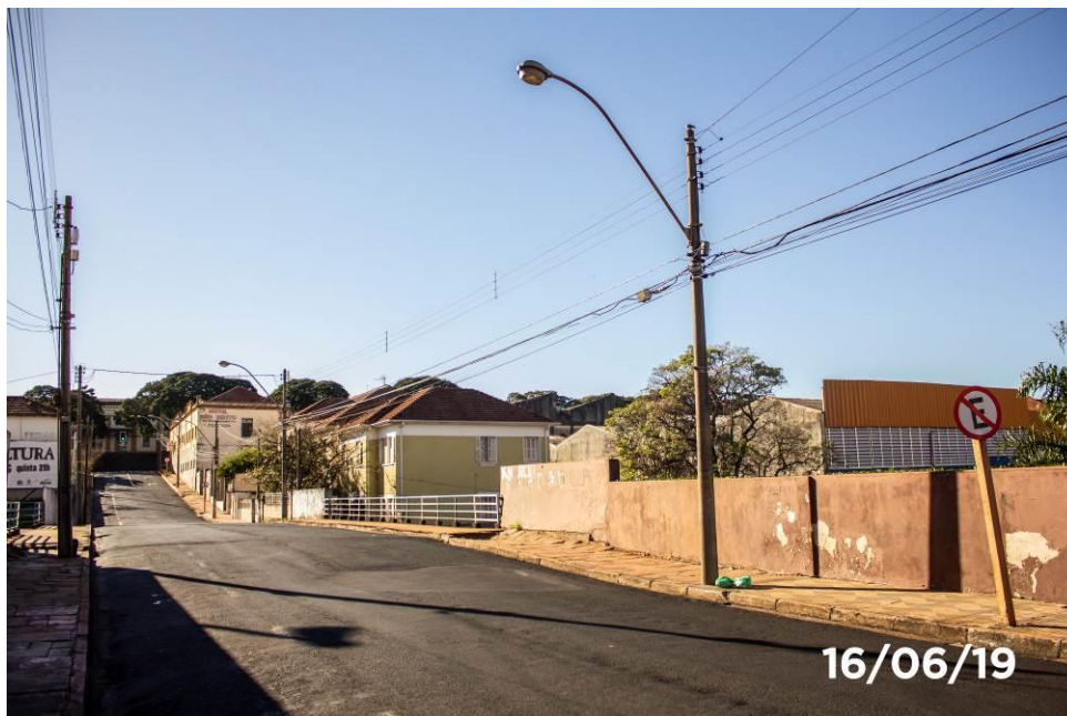
Foto 21: Vista da iluminação sobre o tabuleiro.
