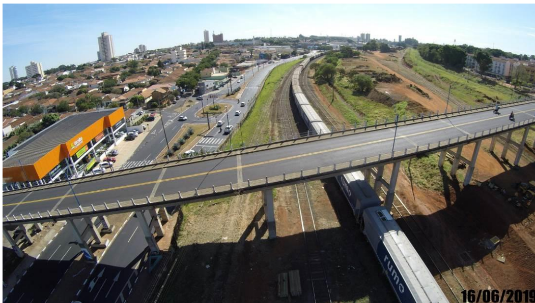
Foto 01: Vista geral da face superior do tabuleiro.
