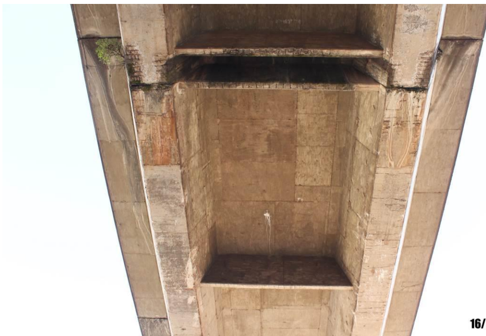
Foto 43: Vista da face inferior do tabuleiro com armadura exposta, eflorescência e vegetação dentro da junta de dilatação.
