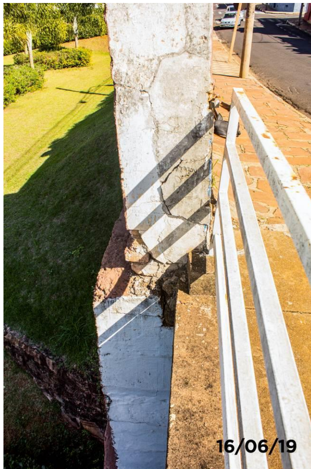
Foto 14: Detalhe do guarda corpo sem conexão com o muro e também apresentando corrosão.
