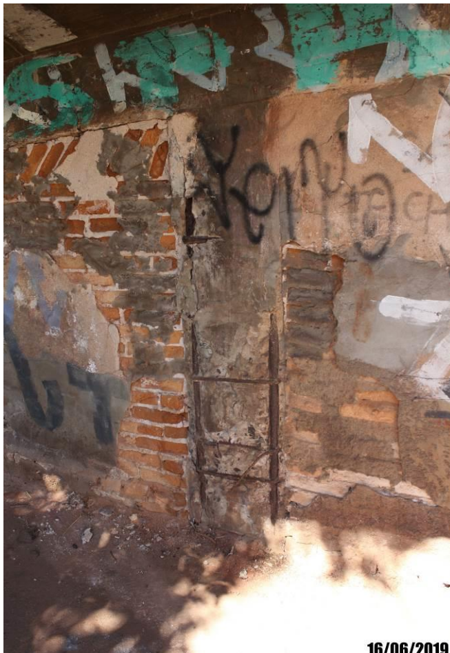
Foto 63: Detalhe de armadura exposta do muro ala.
