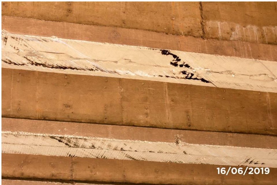
Foto 25: Detalhe das vigas com deslocamento de concreto, armaduras expostas e rompidas.
