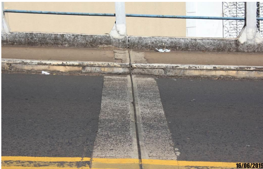
Foto 09: Vista com lábio polimérico da calçada danificada e junta de dilatação danificada.
