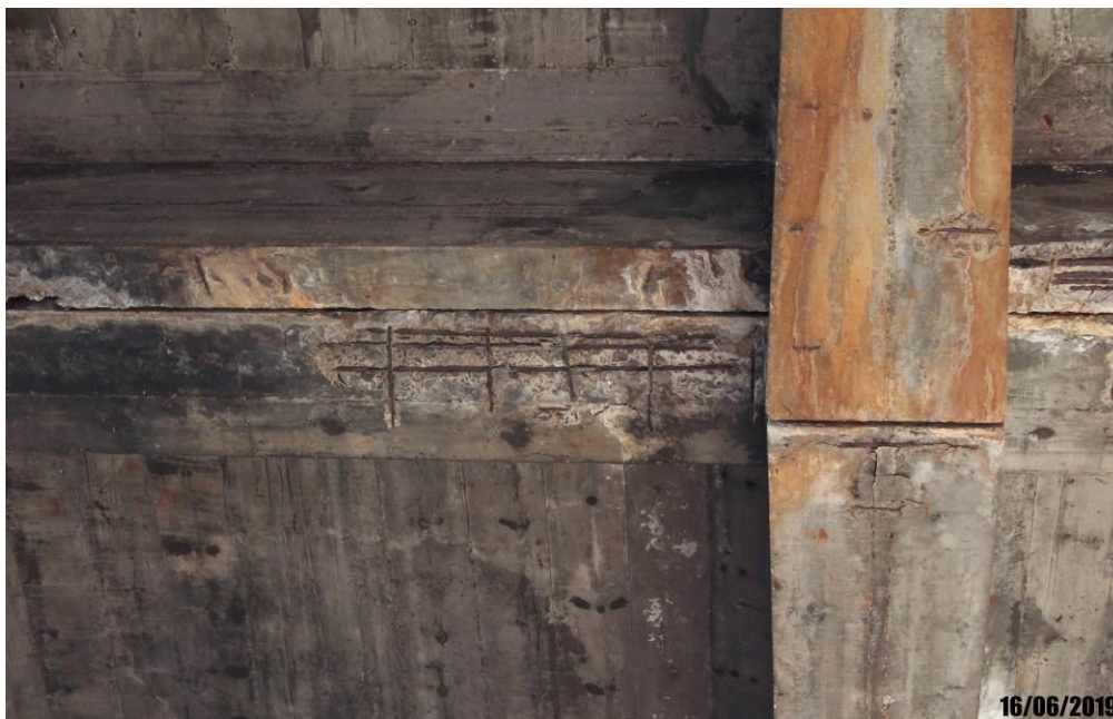
Foto 49: Detalhe de armadura exposta, eflorescência e infiltração na face inferior do tabuleiro.
