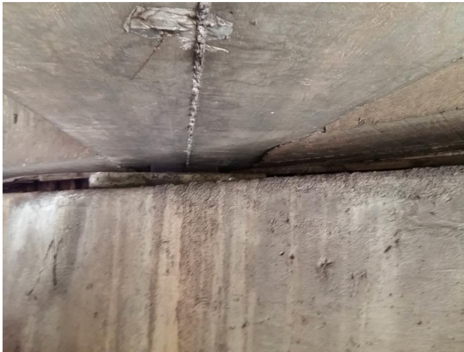
Foto 40: Detalhe do neoprene das extremidades.
