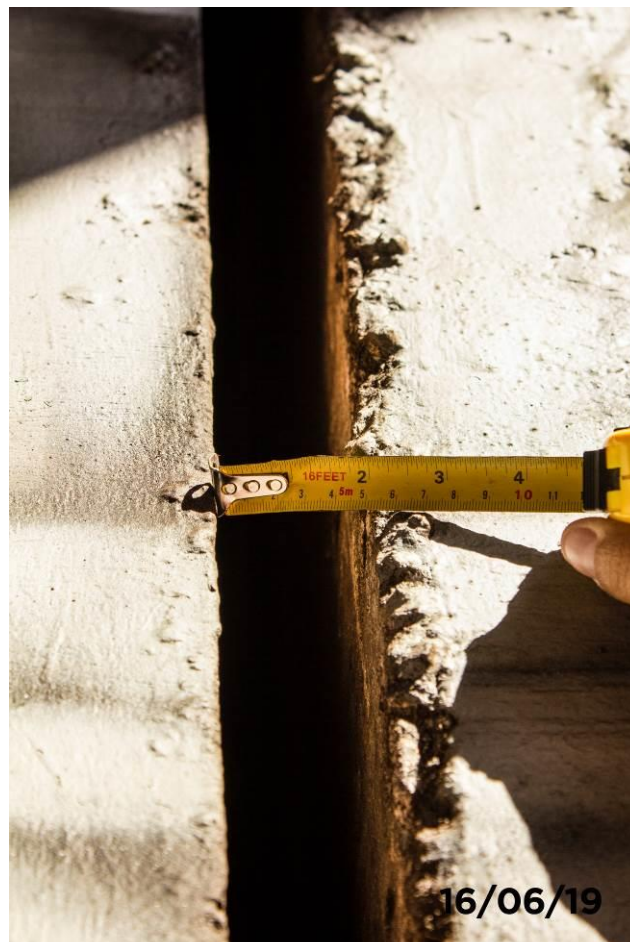
Foto 42: Detalhe da dilatação no muro de arrimo.
