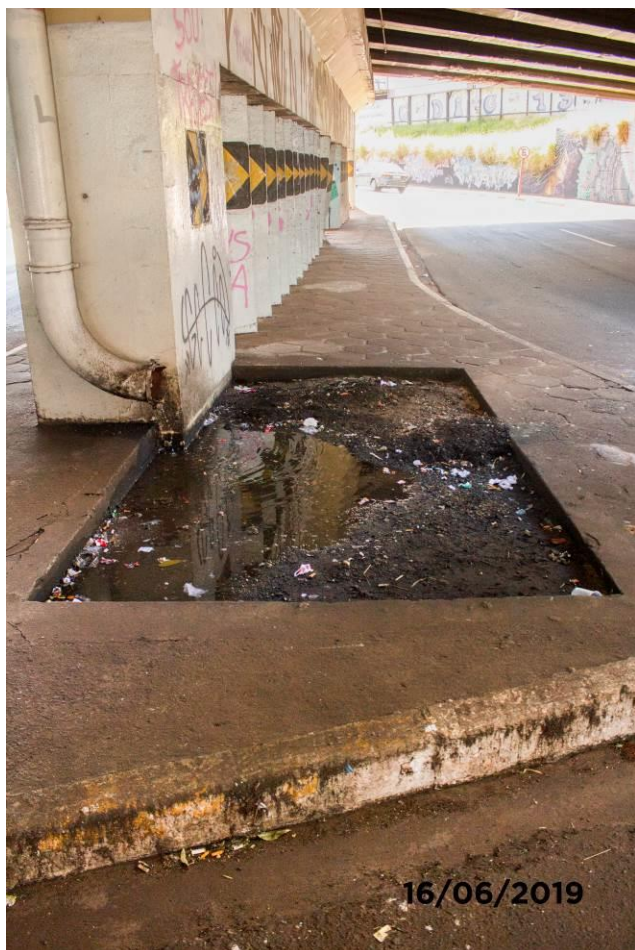
Foto 38: Tubulação de água do terminal rodoviário sendo depositada no pé do pilar.
