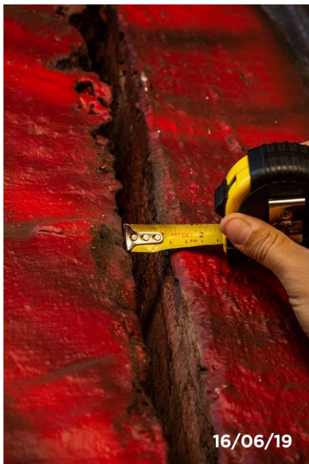
Foto 39: Detalhe da dilatação no muro de arrimo.
