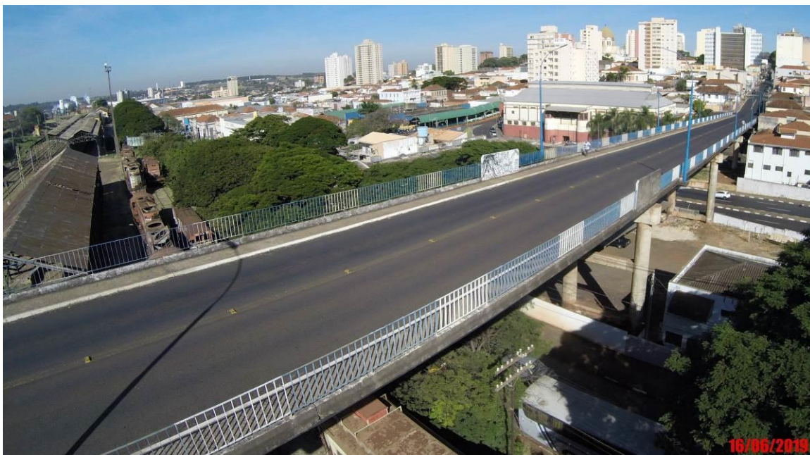
Foto 01: Vista geral da face superior do tabuleiro.
