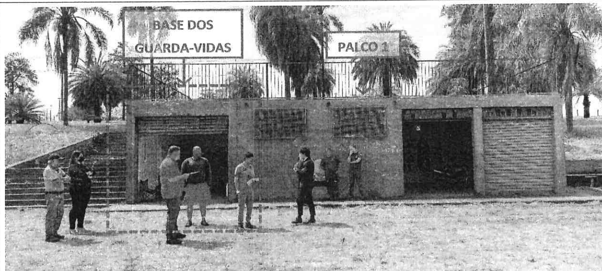
Imagem 2: Edificação onde está localizada a base dos guarda-vidas, sob o Palco 1.
