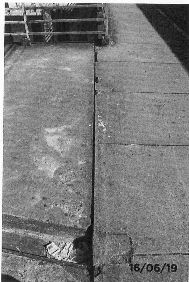
Foto 13: Vista da Junta de dilatação com os lábios poliméricos deteriorados.
