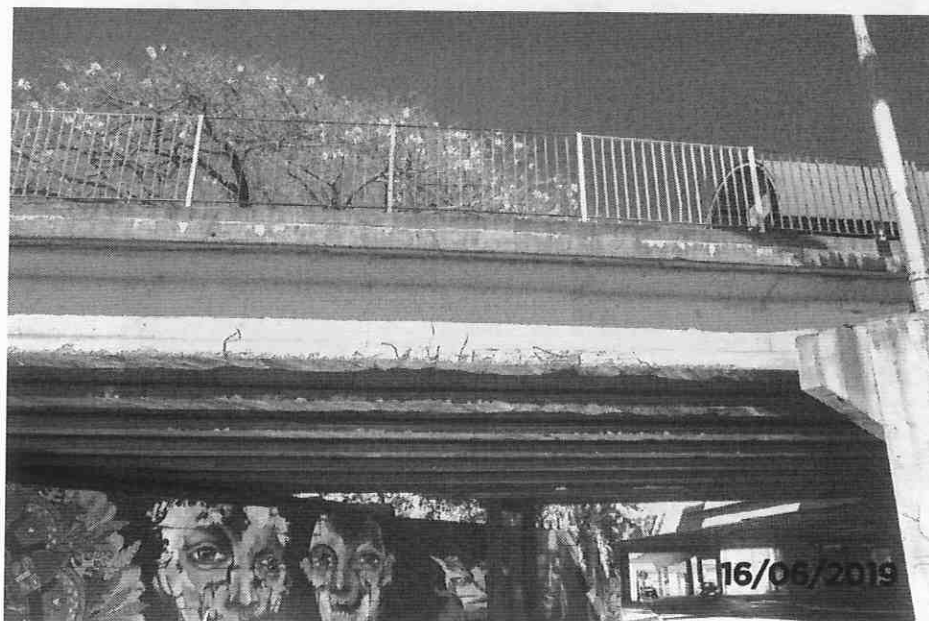
Foto 26: Detalhe das vigas com deslocamento de concreto, armaduras expostas e rompidas.
