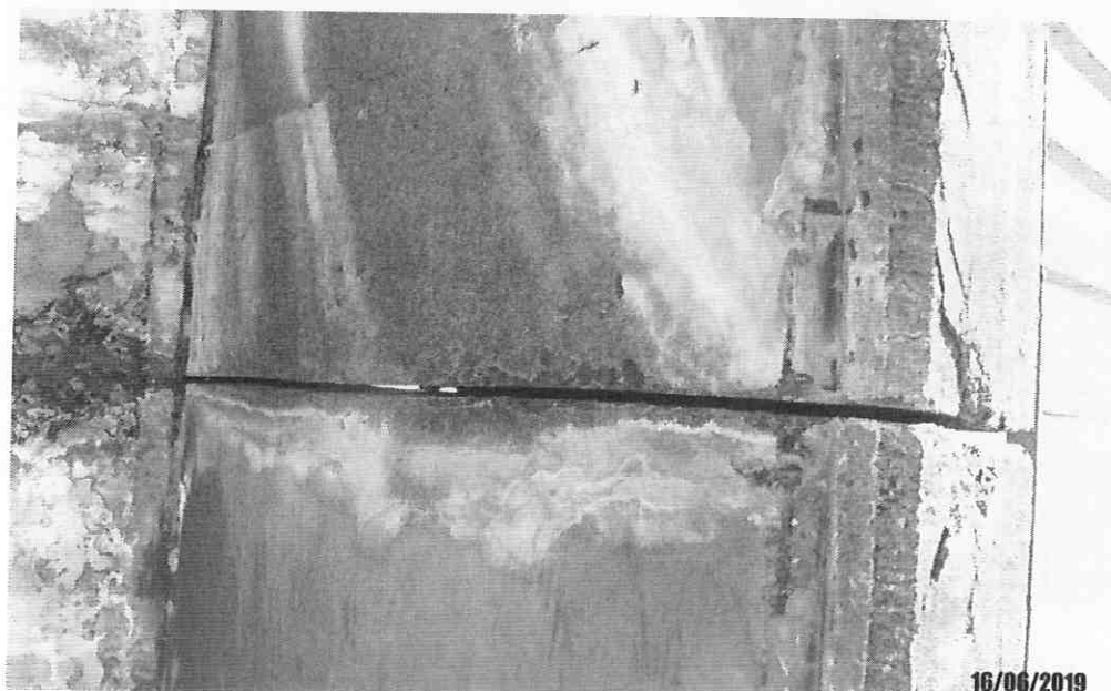
Foto 33: Detalhe de armadura exposta na pingadeira e infiltração com eflorescência na junta de dilatação da calçada.
