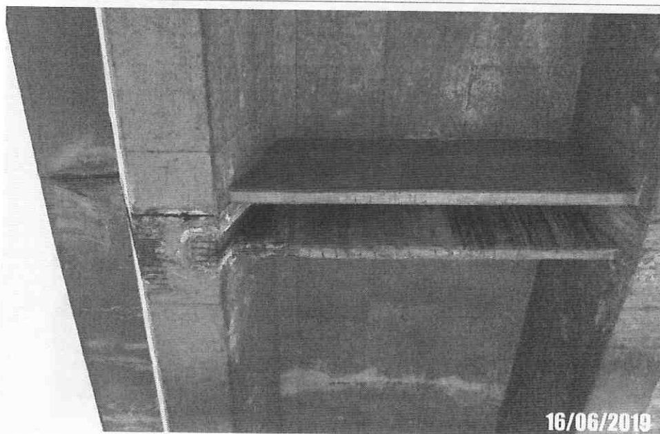
Foto 44: Detalhe da face inferior do tabuleiro com armadura exposta e infiltração, devido a patologiana junta de dilatação.
