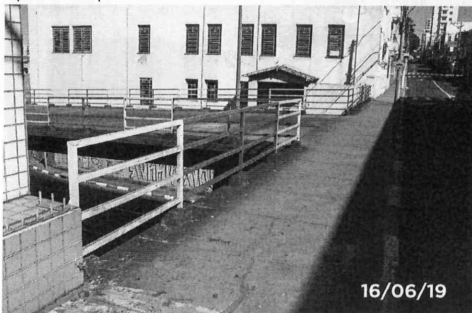
Foto 17: Vista dos pontos de corrosão, vegetação no bloco de apoio com o passeio.
