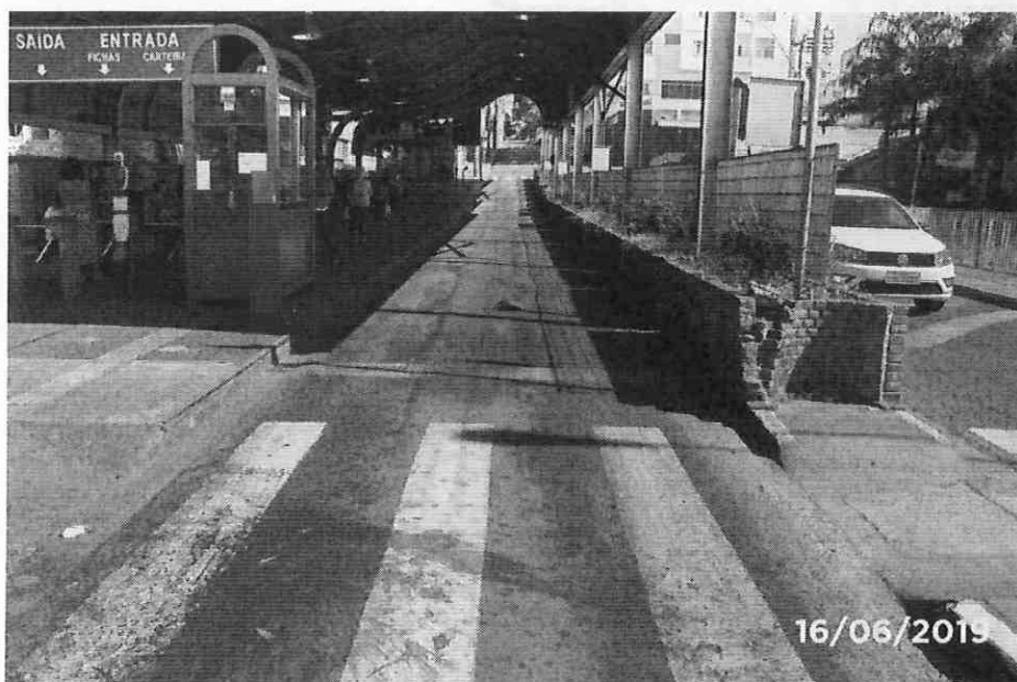
Foto 01: Vista da face superior do tabuleiro.
