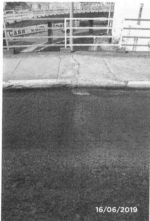
Foto 05: Vista da fissura no pavimento asfáltico e no passeio entre o encontro do viaduto e a via.
