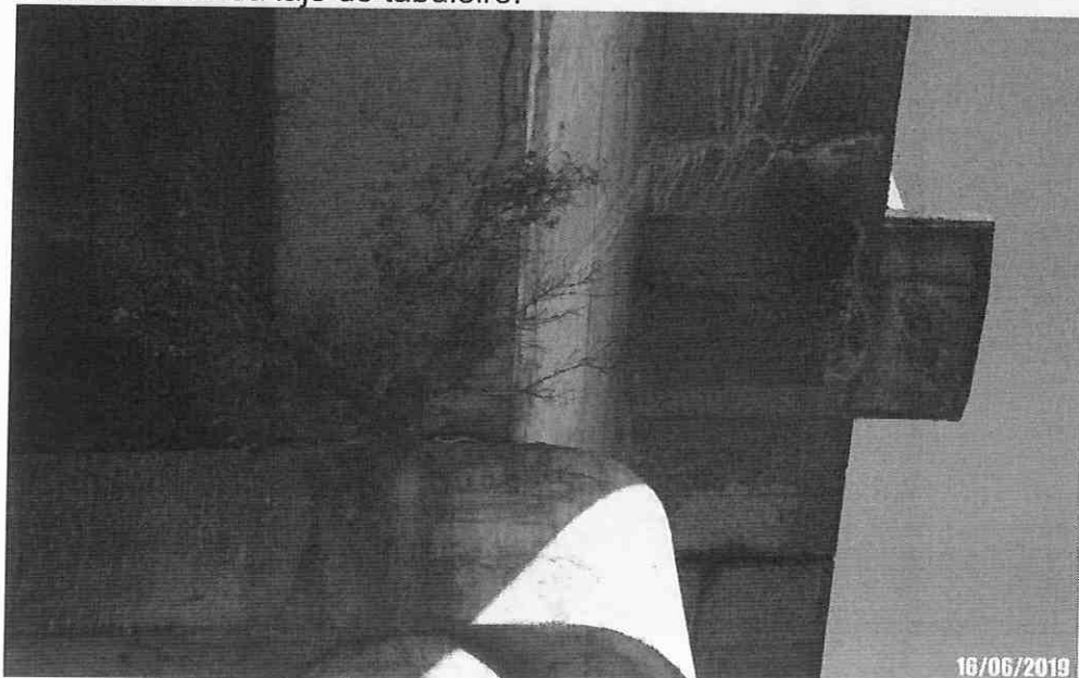
Foto 53: Detalhe de eflorescência e armadura exposta na face inferior do tabuleiro vegetação na ligação entre a viga e o pilar.
