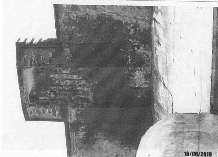
Foto 36: Detalhe de armadura exposta na face inferior do tabuleiro, lateral da viga principal e fissura na face inferior do tabuleiro.
