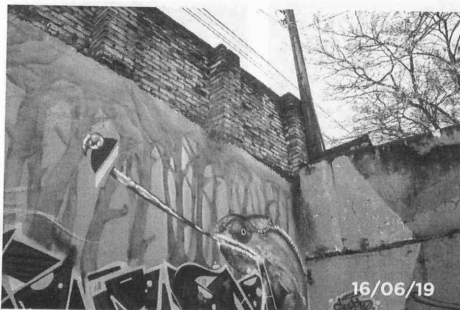
Foto 43: Detalhe de vegetação no muro de arrimo.
