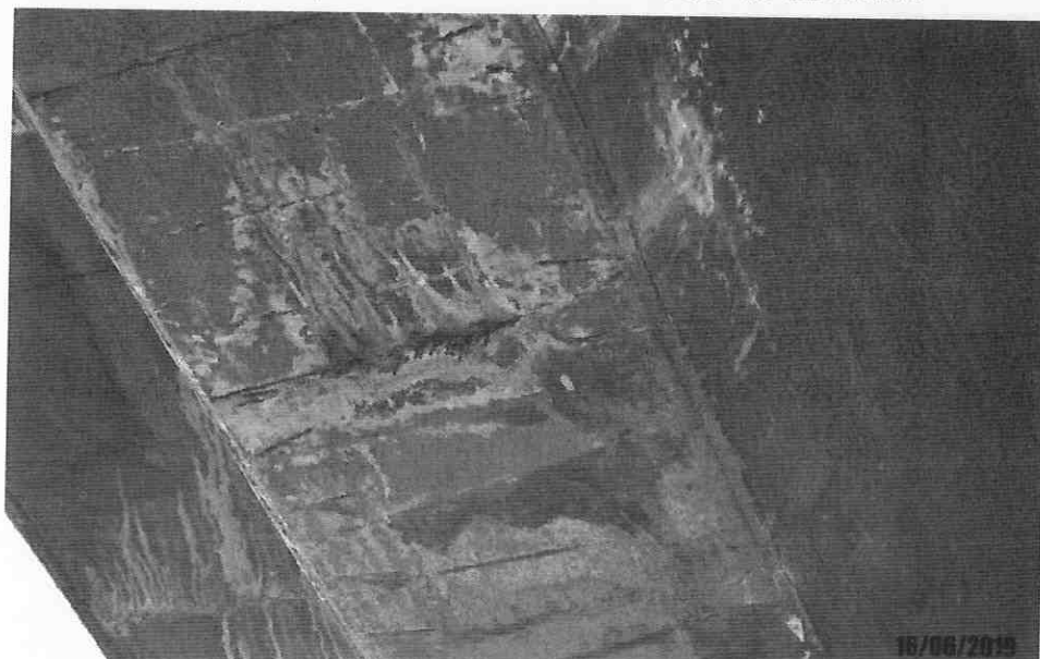
Foto 37: Detalhe de armadura exposta e fissura na face inferior da viga principal.
