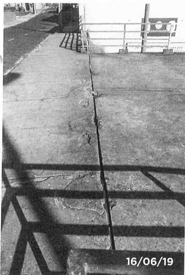
Foto 16 - Detalhe da junta de dilatação entre Av. Brasil e a Passarela, apresentando segregação do concreto, trincas, deslocamento do concreto do Passeio.
