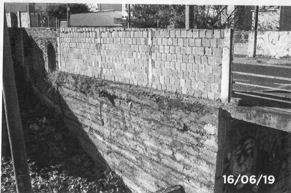
Foto 44: Detalhe de vegetação no muro de arrimo.
