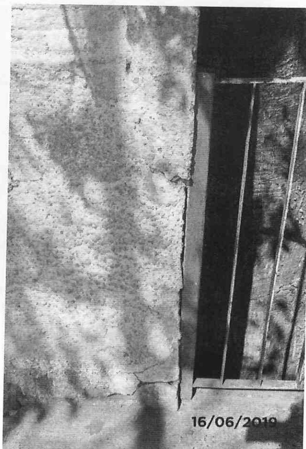
Foto 12: Detalhe da trinca na fixação do guarda corpo e o muro.
