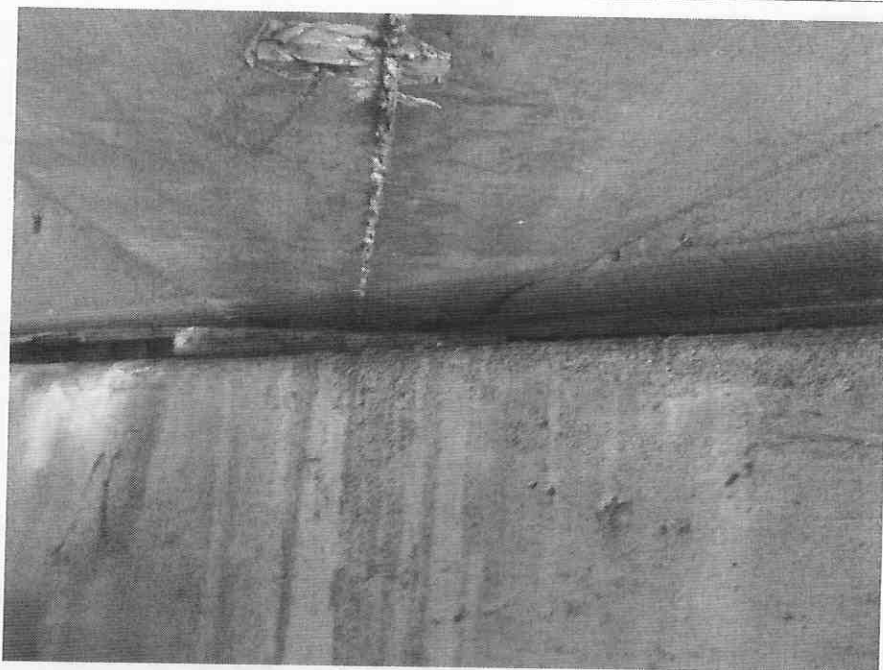
Foto 40: Detalhe do neoprene das extremidades.
