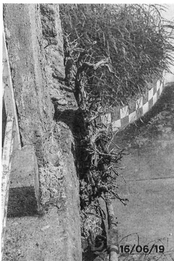
Foto 46: Detalhe da vegetação no muro de arrimo.
