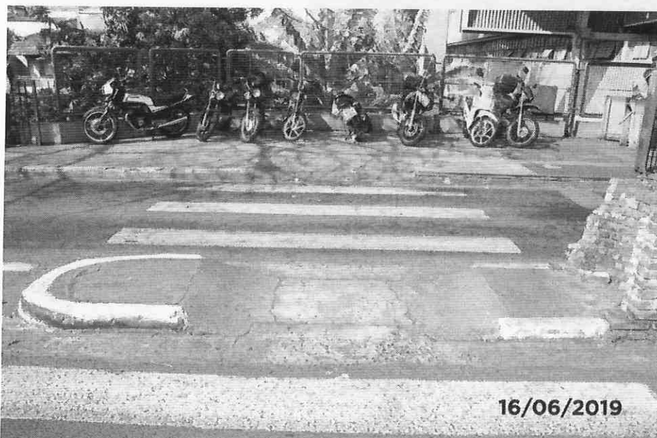
Foto 09: Detalhe do acesso ao passeio central e no passeio saindo do terminal rodoviário com a marcação de acessibilidade apagada e apresentando fissuras.
