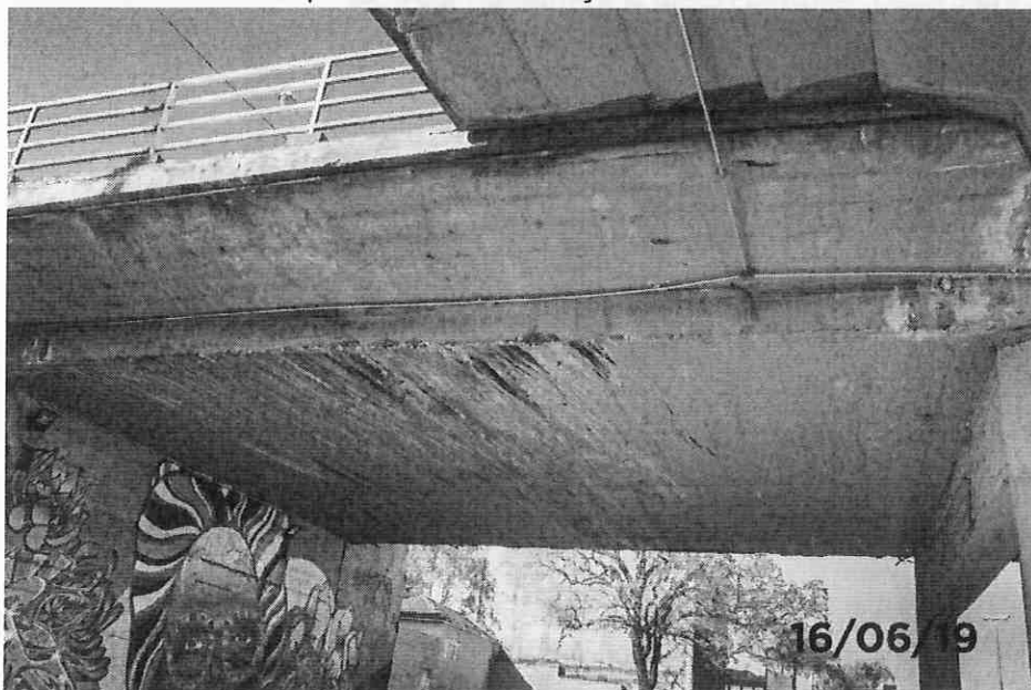
Foto 24: Vista da face inferior do tabuleiro apresentando armadura exposta, deslocamento de concreto, infiltração, eflorescência e tubulação elétrica.
