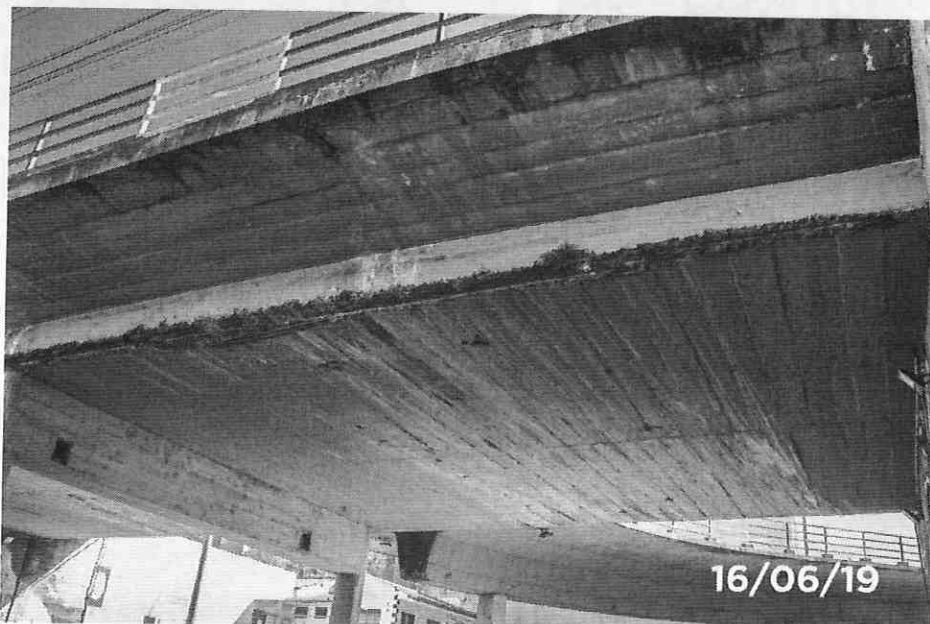
Foto 22: Vista da face inferior do tabuleiro com armadura exposta, deslocamento de concreto, infiltração, eflorescência e rompimento de tubulação elétrica.
