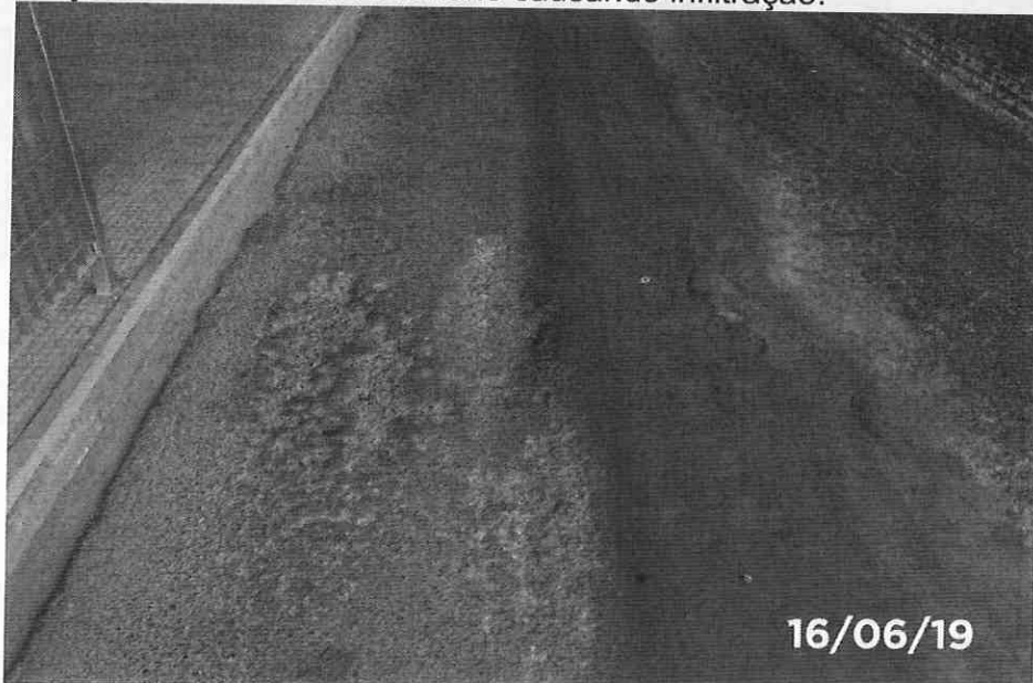
Foto 04: Detalhe da deterioração do pavimento flexível do tabuleiro.
