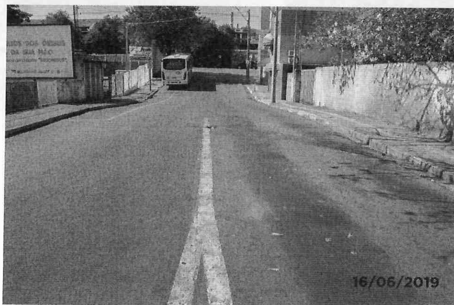
Foto 04: Vista da junta de dilatação no encontro.
