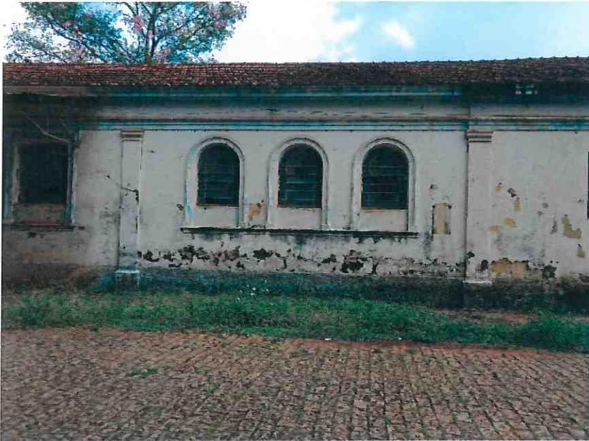
Foto 03. É possível verificar o piso externo, os detalhes da fachada principal, vãos, cobertura. A parede encontra-se bem deteriorada. Fonte. Conselheiros
