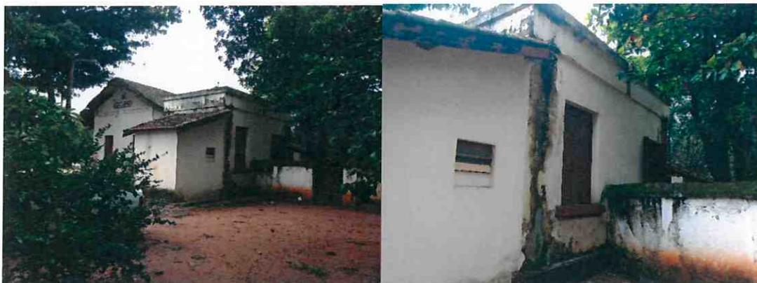
Foto 01 e 02 da Estação de Bueno vista dos fundos, onde é perceptível a casa acoplada a Estação, e os sanitários (ampliação) como anexo. Pelas imagens pode-se observar que há problemas de umidade, sujidade. Fonte. Conselheiros
