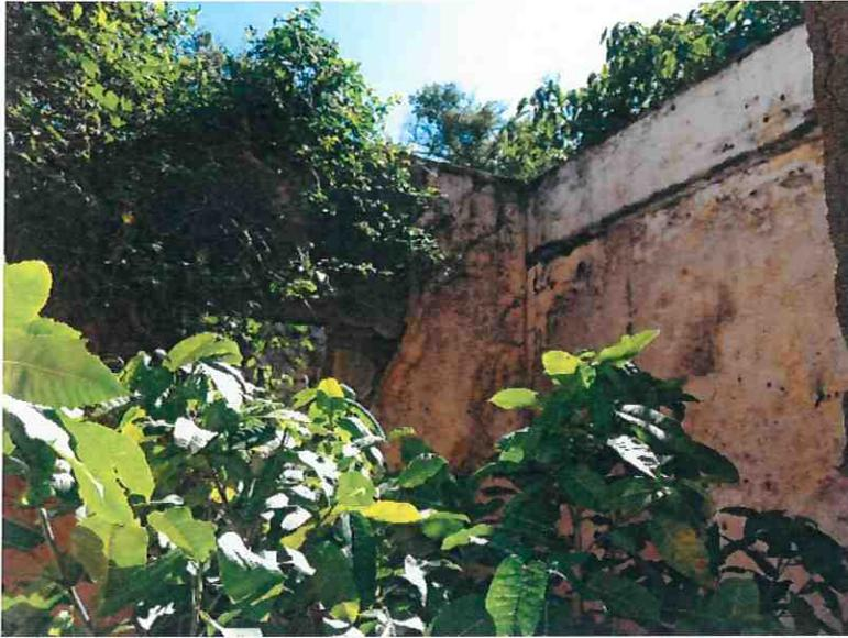
Foto 02. Interna da edificação que demonstra o estado de conservação precário da construção. Não possui mais cobertura, nem estrutura. Na alvenaria há somente vãos, não há esquadrias. Piso não existe mais. Fonte. Conselheiros
