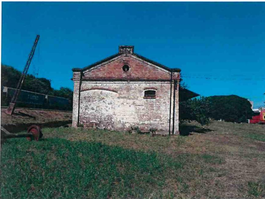
Foto 01. Lateral da edificação. O que permite verificar o material da alvenaria, tijolo de barro. E que houve intervenções ao longo dos anos. Fonte. Conselheiros
