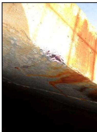
Vista da aspersão da solução de fenolftaleína em parede do reservatório
