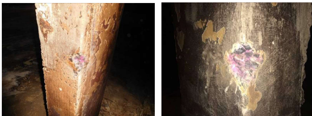
Vista da aspersão da solução de fenolftaleína em pilares das câmaras 1 e 2
