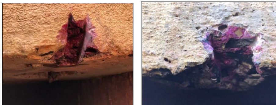
Vista da aspersão da solução de fenolftaleína nas lajes de cobertura das câmaras 1 e 2
