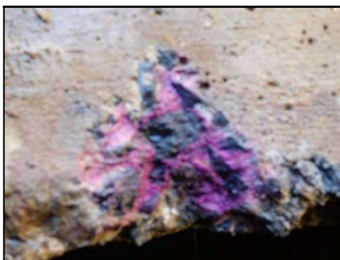
Vista da aspersão da solução de fenolftaleína em parede do reservatório
