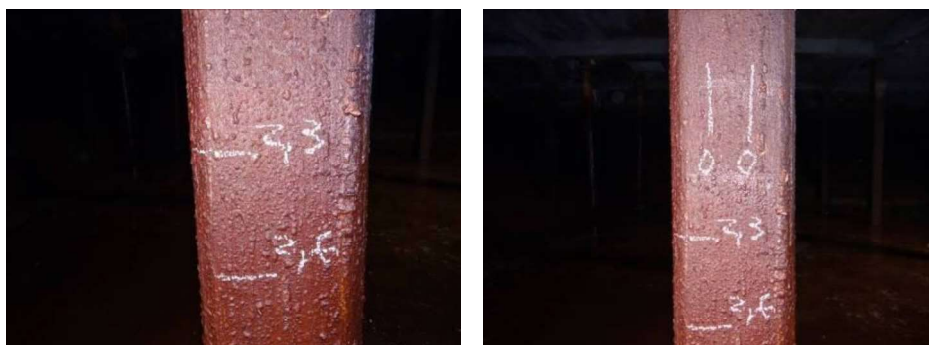
Detalhe do ensaio de pacometria em pilares
