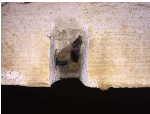
Vista da aspersão da solução de fenolftaleína na laje de cobertura
