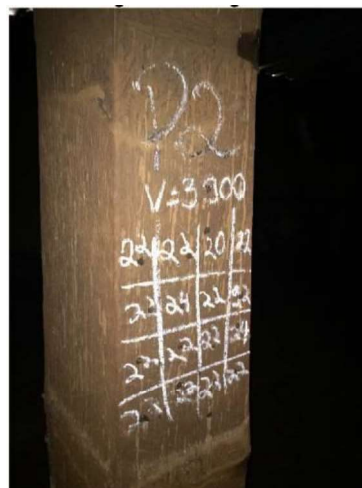
Vista ensaio no pilar 2
