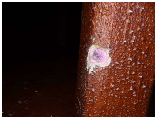
Vista da aspersão da solução de fenolftaleína em pilar
