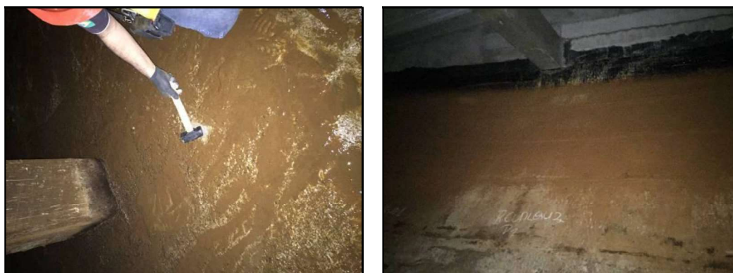
Vista interna do piso e lateral
