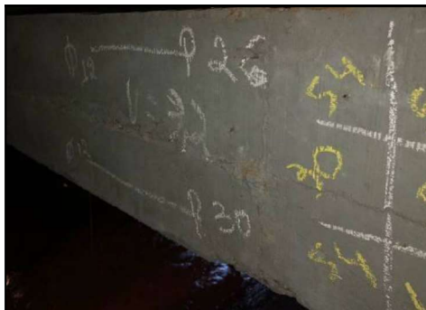
Vista ensaio no pilar 2
