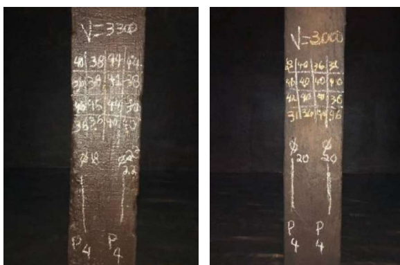
Vista ensaio em pilares internos das câmaras 1 e 2
