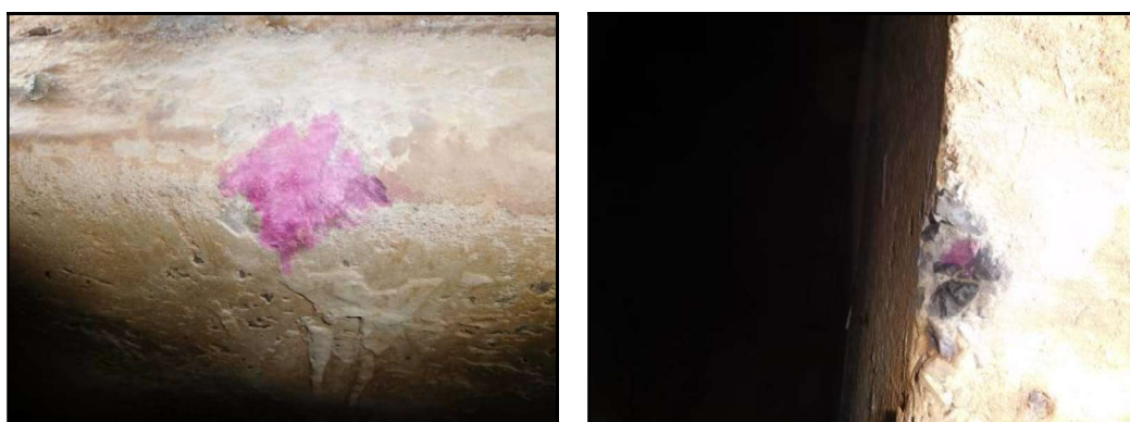
Vista da aspersão da solução de fenolftaleína em paredes internas
