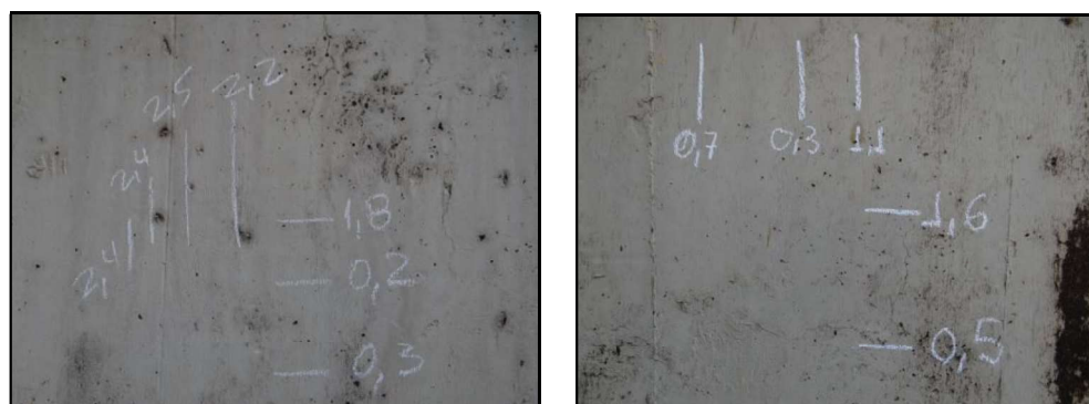
Detalhe do ensaio de pacometria em parede e pilar da câmara 1 e 2
