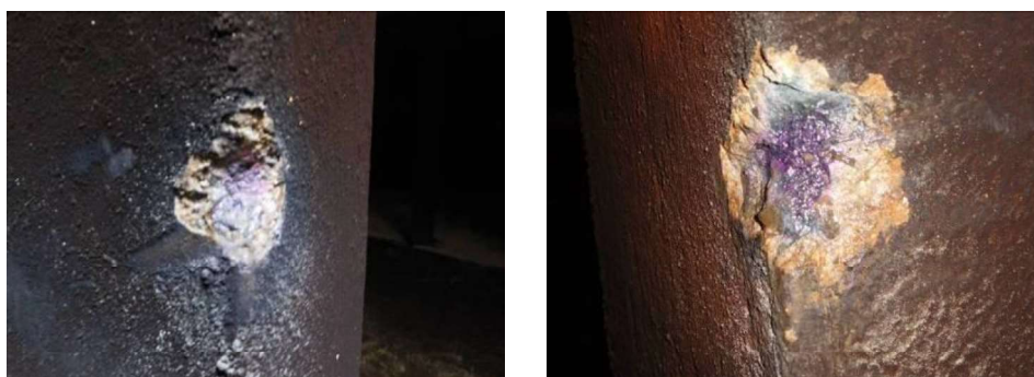
Vista da asperção da solução de fenolftaleína em pilares das câmaras 1 e 2
