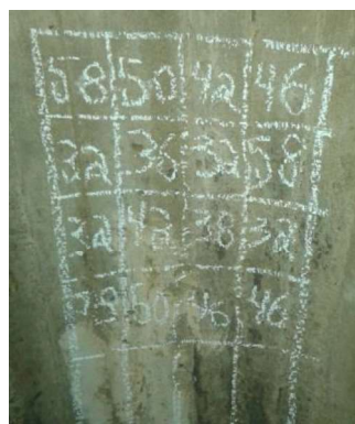
Vista do local de execução do ensaio
