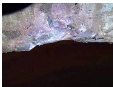
Vista da asperção da solução de fenolftaleína na laje de cobertura
