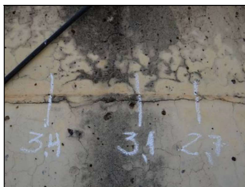
Detalhe do ensaio de pacometria em parede e pilar da câmara 1
