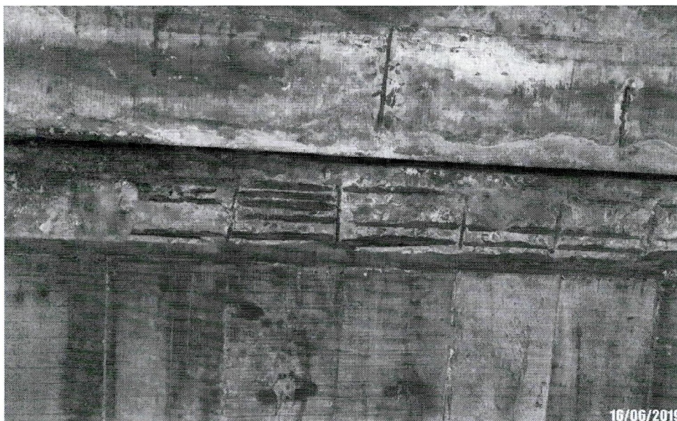
Foto 56: Detalhe de armadura exposta, eflorescência, infiltração, deslocamento de concreto e lodo na face inferior do tabuleiro.
