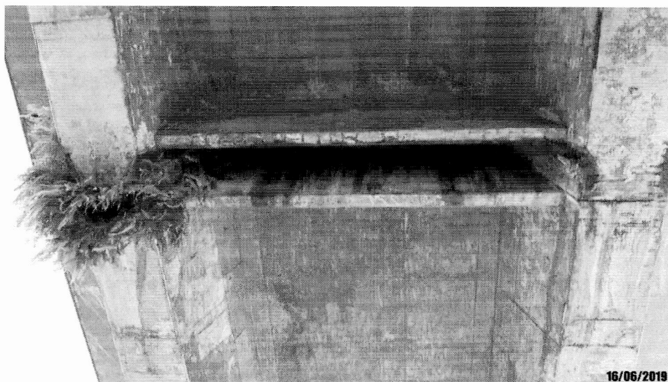
Foto 44: Detalhe da face inferior do tabuleiro com armadura exposta e infiltração, devido a patologia na junta de dilatação.
