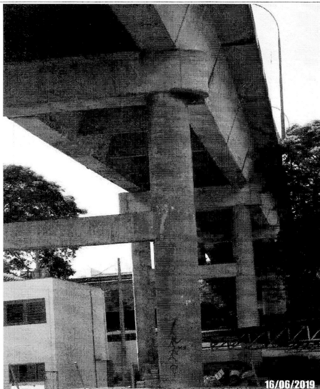
Foto 54: Vista de pilares com pequenas fissuras, pontos de deslocamento de concreto e eflorescência.
