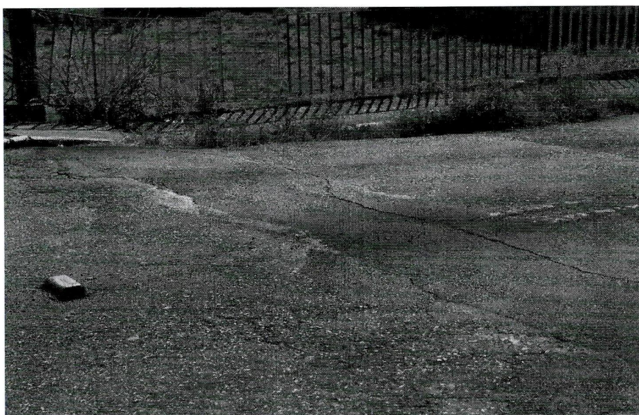
Foto 11: Detalhe do encontro entre o pontilhão e a via com a junta coberta pelo pavimento flexível.
