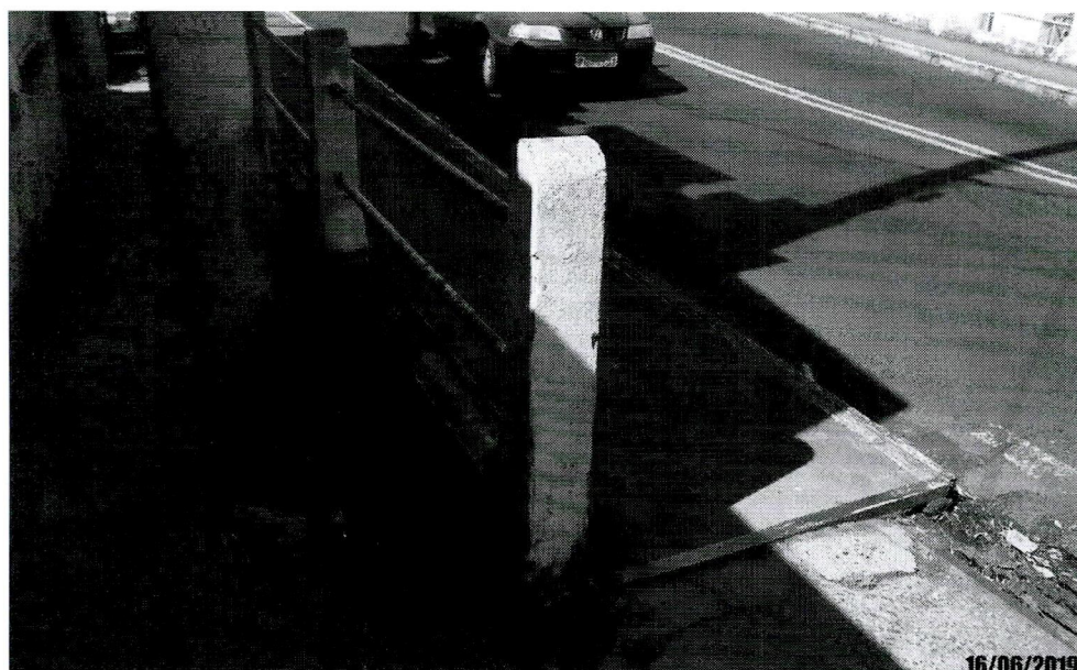
Foto 20: Detalhe do desnível no avesso ao passeio.
