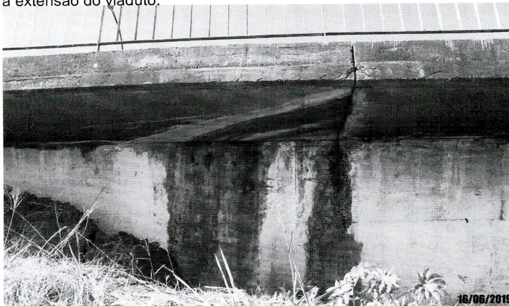
Foto 31: Detalhe de infiltração na viga principal, deslocamento de concreto na face lateral da laje e armadura exposta. Recorrente em toda a extensão do viaduto
