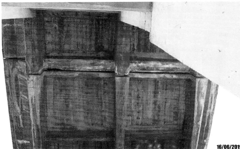
Foto 52: Detalhe de armadura exposta, eflorescência e infiltração na face inferior do tabuleiro.
