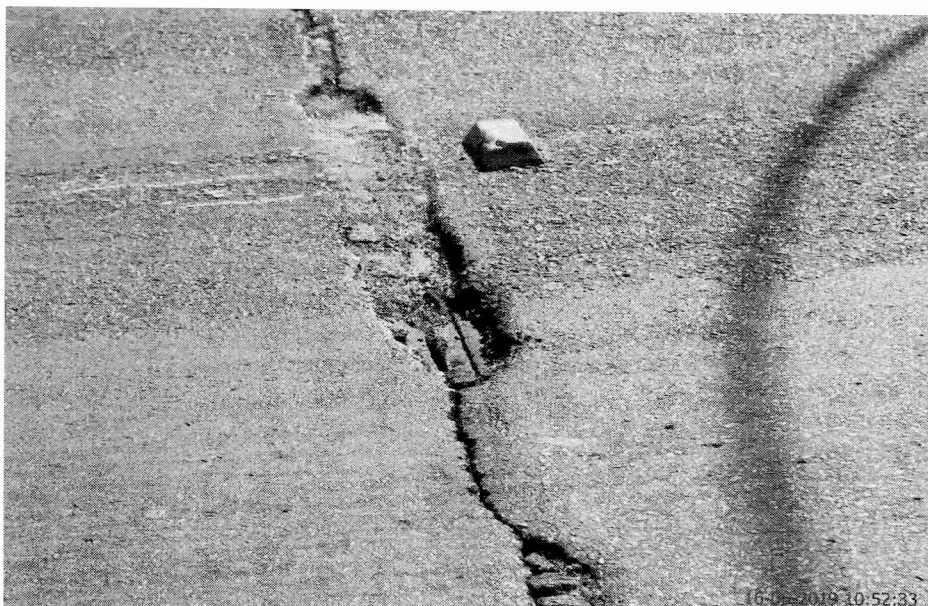
Foto 09: Detalhe da junta de dilatação deteriorada. Todas estão danificadas.
