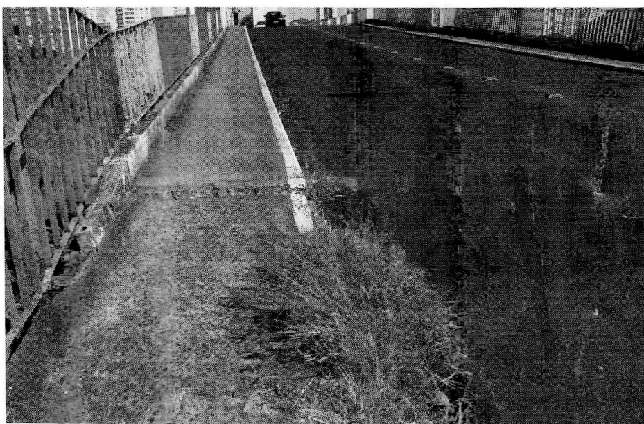
Foto 15: Detalhe do acesso ao passeio contendo desnível.
