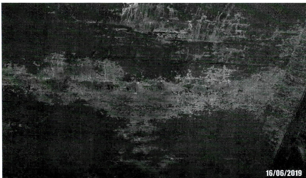
Foto 38: Detalhe de armadura exposta e fissura, infiltração e eflorescência na face inferior do tabuleiro
