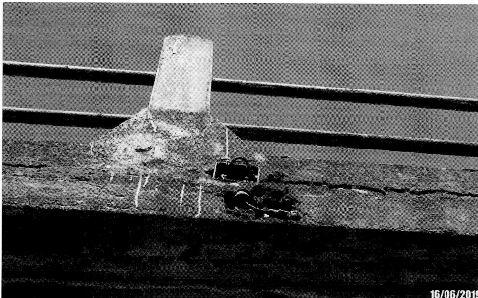
Foto 29: Detalhe de ponto de energia elétrica sem tampa a exposto ao tempo.
