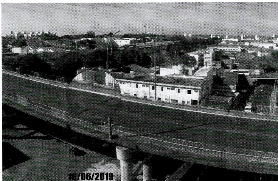
Foto 06: Vista da junta de dilatação deteriorada.
