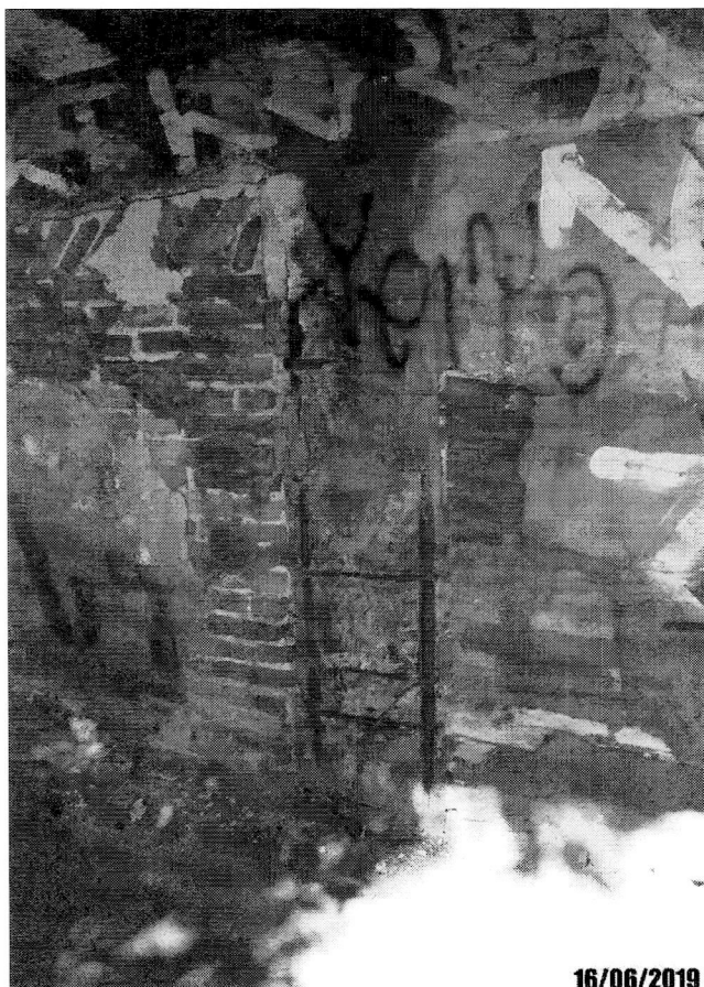
Foto 63: Detalhe de armadura exposta do muro ala.
