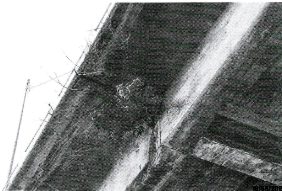
Foto 40: Detalhe de vegetação nascendo dentro da junta de dilatação, na lateral da viga principal.
