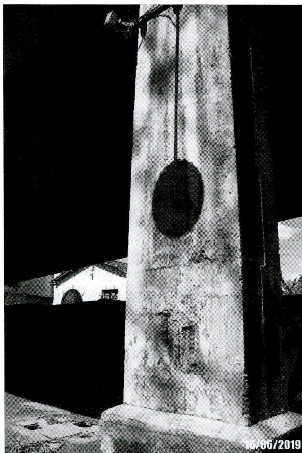
Foto 66: Detalhe de armadura exposta e deslocamento de concreto.
