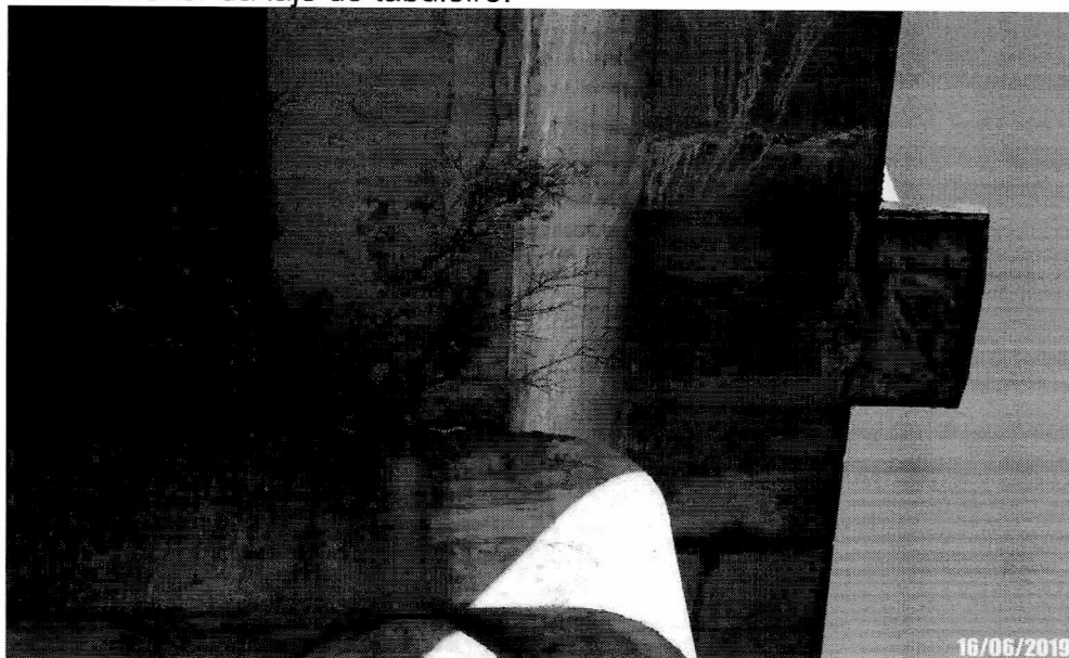
Foto 53: Detalhe de eflorescência e armadura exposta na face inferior do tabuleiro vegetação na ligação entre a viga e o pilar.
