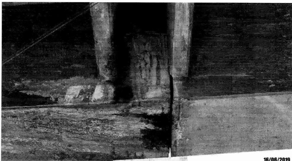
Foto 48: Detalhe da face inferior da viga com armadura exposta, eflorescência e deslocamento de concreto na junta de dilatação.
