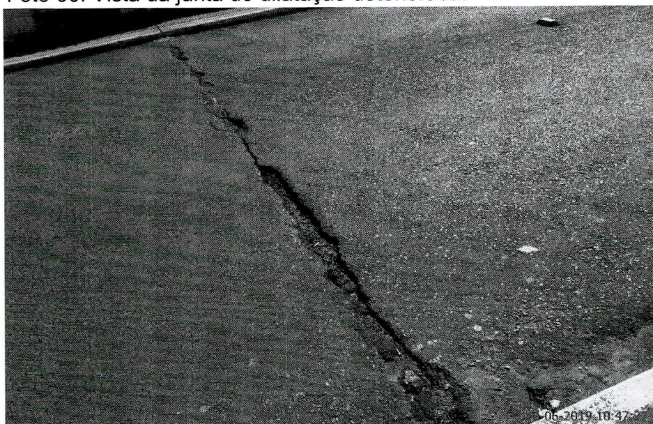
Foto 07: Detalhe da junta de dilatação deteriorada. Todas estão danificadas.
