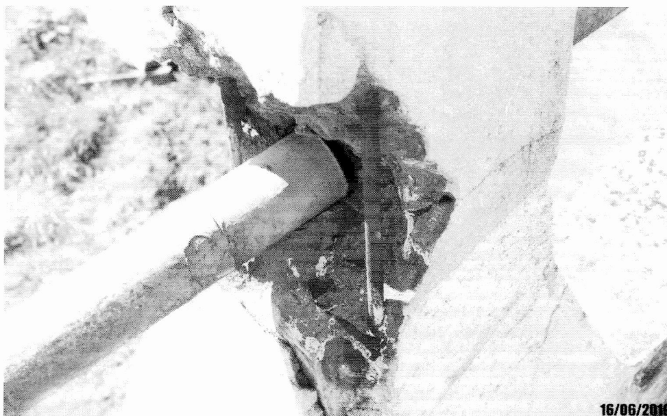
Foto 17: Detalhe do pilarete de concreto com armadura exposta, deslocamento de concreto e barra do guarda corpo soltando da estrutura.
