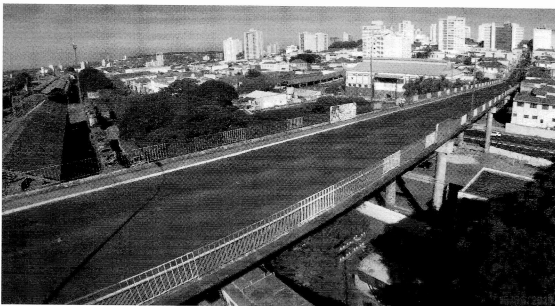
Foto 01: Vista geral da face superior do tabuleiro.
