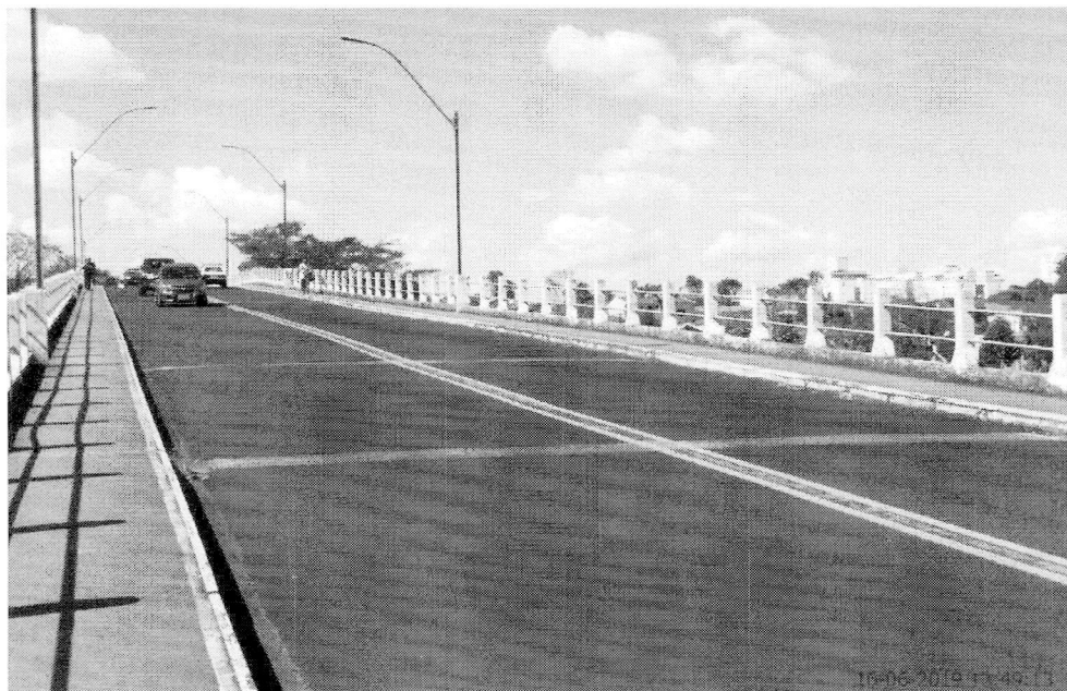
Foto 28: Vista de iluminação sobre o tabuleiro.
