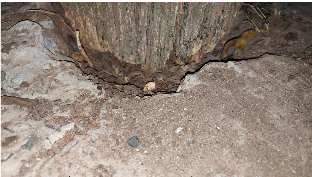
AVENIDA ANTÔNIO FERREIRA LUIZ FILHO, PRÓXIMO AO Nº 84-PARQUE DAS HORTÊNCIAS
