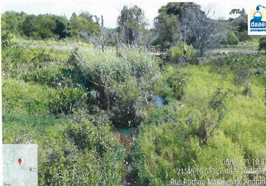
Foto 10: Vista do córrego do Serralhal e Área de Preservação – APP a jusante da Travessia executada.
