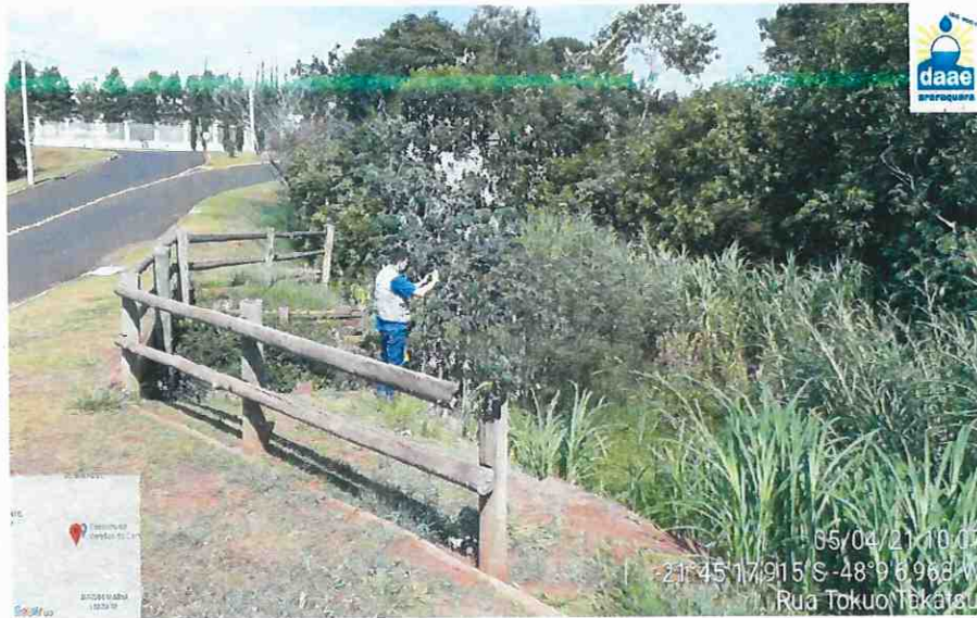
Foto 15: Vista da travessia sobre o córrego do Serralhal e Área de Preservação – APP a montante da Travessia executada (vide PONTO 1 na imagem 1).
