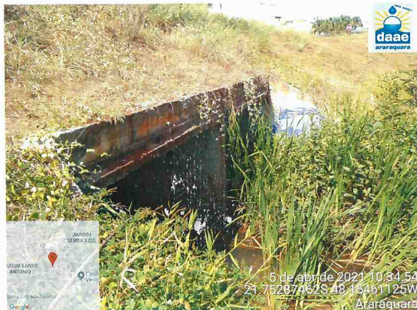
Foto 6: Vista da Travessia executada como obra de infraestrutura e expansão urbana sobre o córrego do Serralhal.
