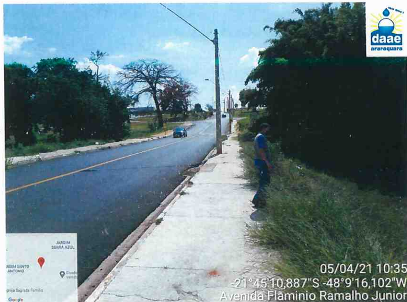
Foto 5: Vista da Travessia executada como obra de infraestrutura e expansão urbana sobre o córrego do Serralhal.
