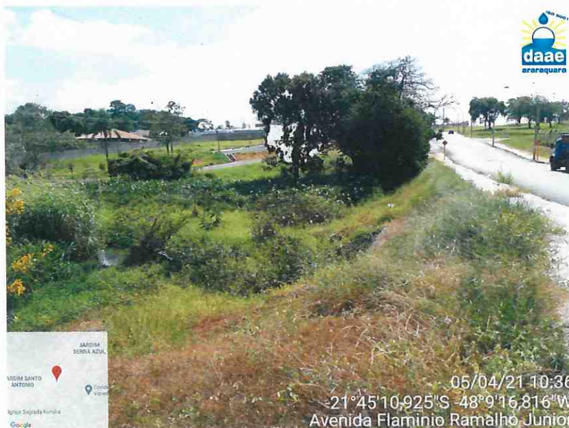
Foto 9: Vista do córrego do Serralhal e Área de Preservação – APP a jusante da Travessia executada.
