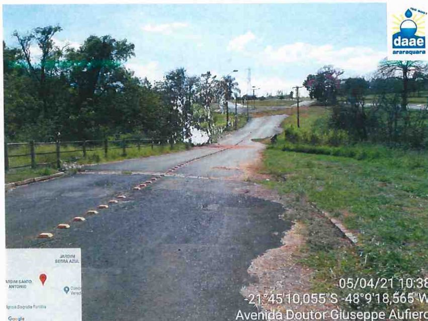
Foto 11: Vista travessia em madeira (desativada) e utilizada anteriormente à executada em 2017/2018 em função da obra de infraestrutura e expansão urbana no local.
