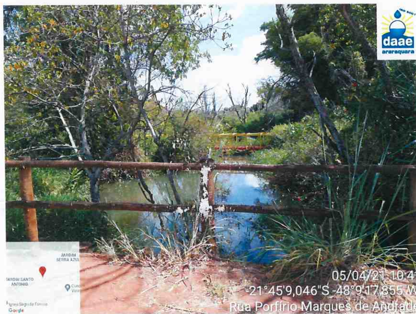
Foto 12: Vista do córrego do Serralhal e Área de Preservação – APP a jusante da travessia de madeira desativada.
