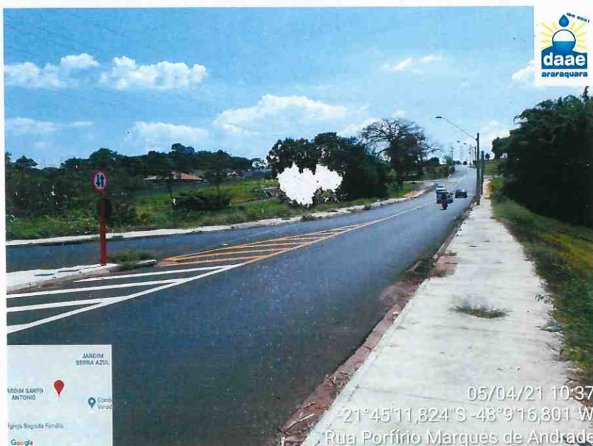
Foto 4: Vista da Travessia executada como obra de infraestrutura e expansão urbana sobre o córrego do Serralhal.
