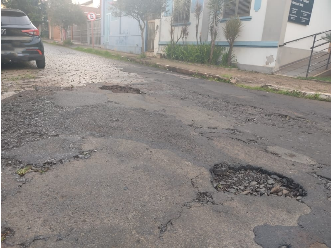
AV. BANDEIRANTES EM FRENTE Nº 222 E 225, ESQUINA COM A RUA MAJOR CARVALHO FILHO – CENTRO
