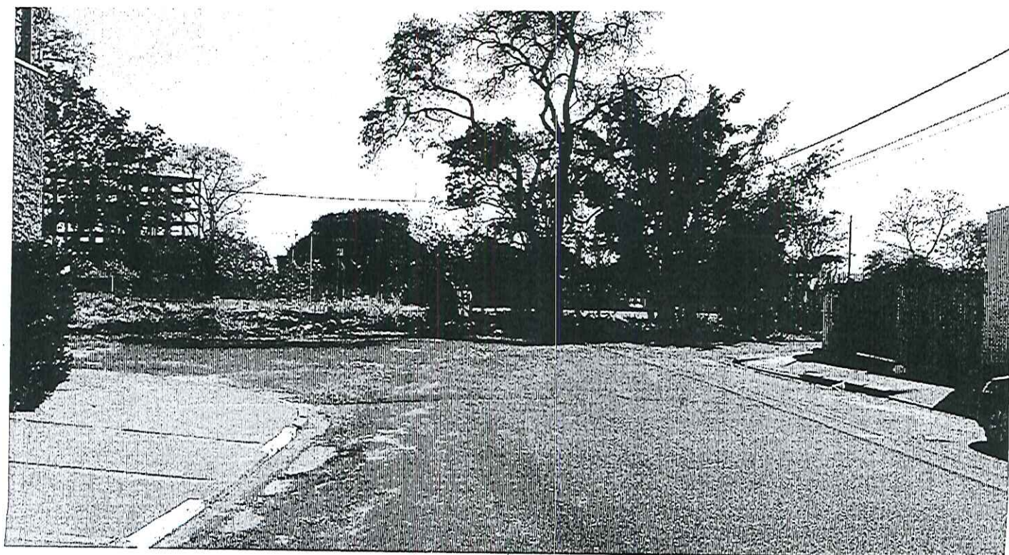
Sinalização Avenida Rolando Tripoli Volpe.
