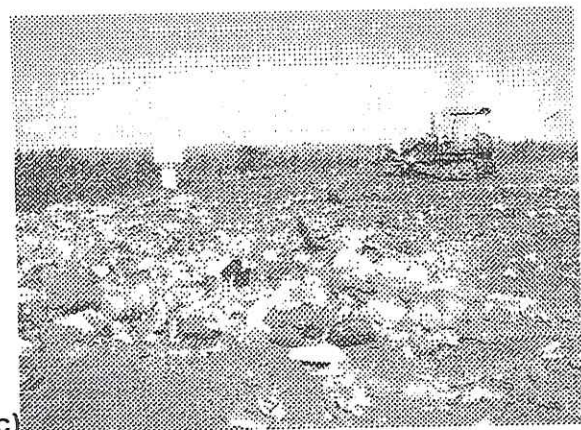
Figura 1. Aterro sanitário: (a) abertura de valas para o recebimento do lixo doméstico; (b) chegada do lixo doméstico; (c) cobertura da vala com terra.
